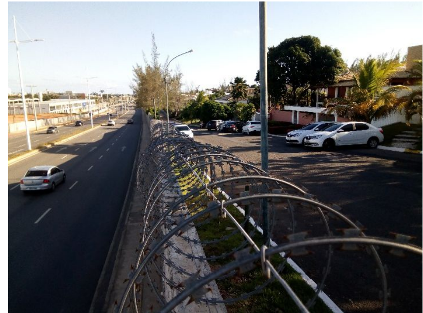
Aparato de segurança do condomínio Parque Costa Verde.
