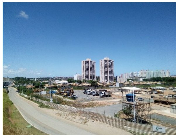
Canteiro de obras na Av. Orlando Gomes
