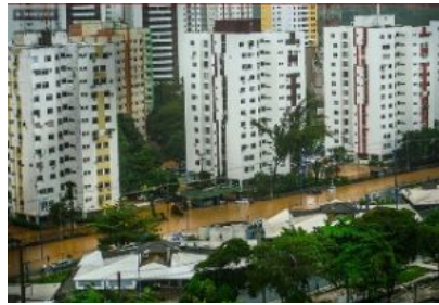
Alagamento no Imbui, ao lado do o Rio das Pedras canalizado.
