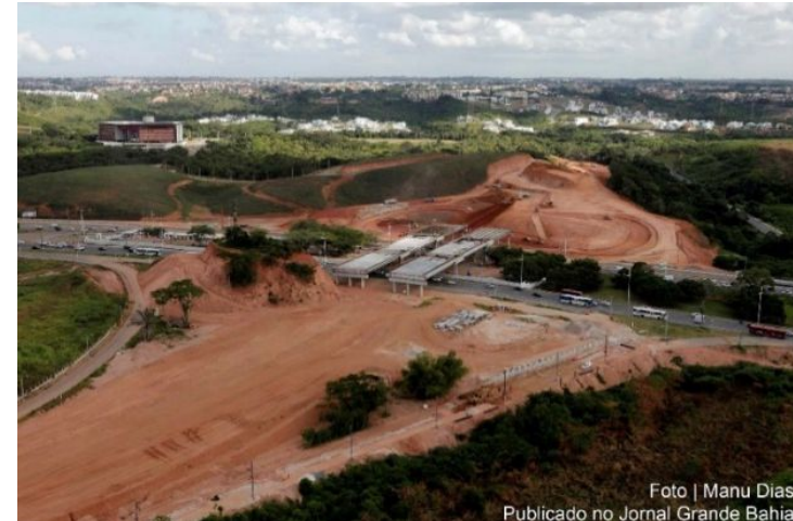
Construção da Av. 29 de Março.
