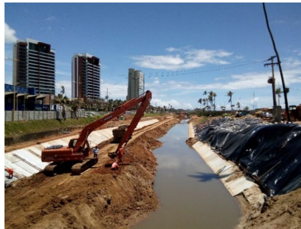
Obra de canalização do rio Jaguaribe.
