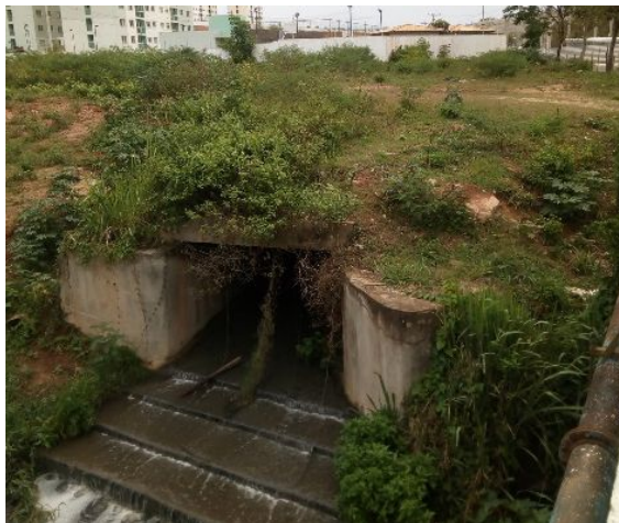
Corrego canalizado desagua no rio Mangabeira
