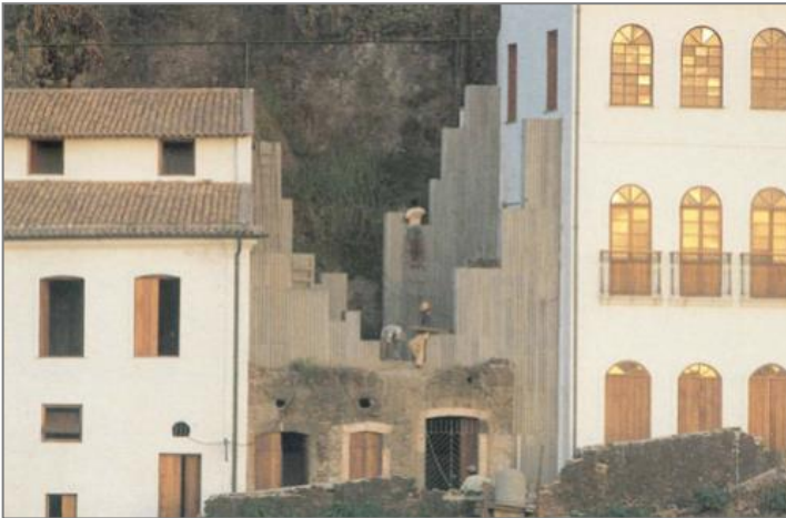
Ilustração 47: Detalhe dos contrafortes em argamassa armada e a estrutura branca Fonte: http://img.interempresas.net/fotos/416489.jpeg .
