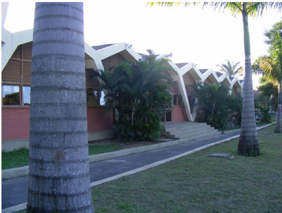
Figura 46 – Foto do Pavilhão Refeitório e Serviços da Escola Parque
