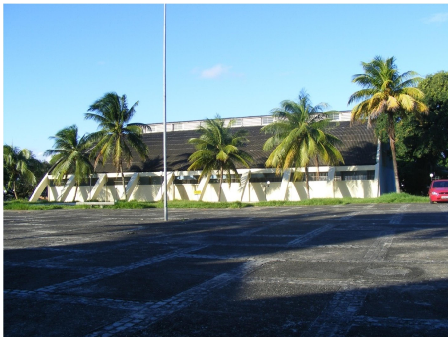
Figura 51 – Foto do Pavilhão de Esportes
