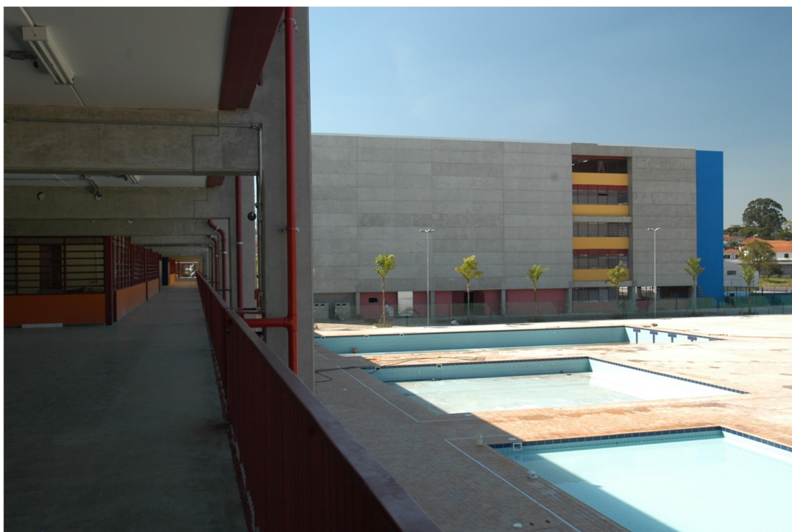
Figura 40 – Balneário e Bloco Cultural e Desportivo, ao fundo
