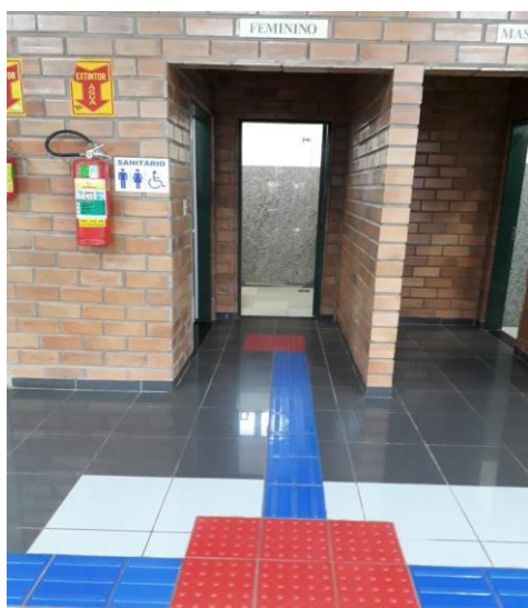
Figura 6 – Acesso aos banheiros.
