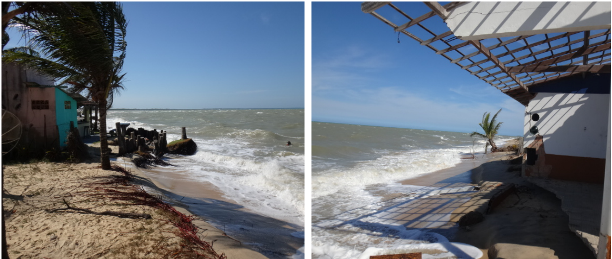
Figuras 7 (A e B) – Erosão na porção Norte da Ponta do Corumbau. Fotos do autor, dezembro de 2015.
