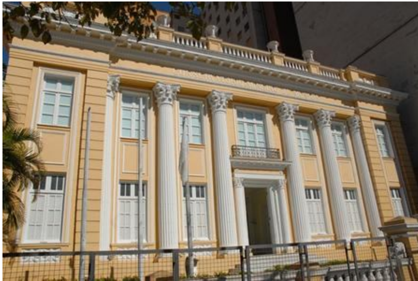
Figura 48 - Foto do antigo Conservatório de Música da UFMG depois de restaurado
