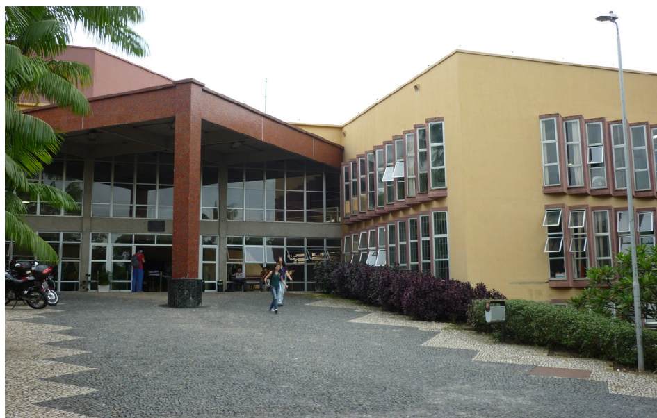
Figura 53 - Vista do prédio atual da Escola de Música da UFMG
