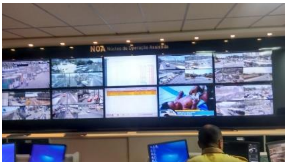
Figura 28 – Sala de controle do NOA
