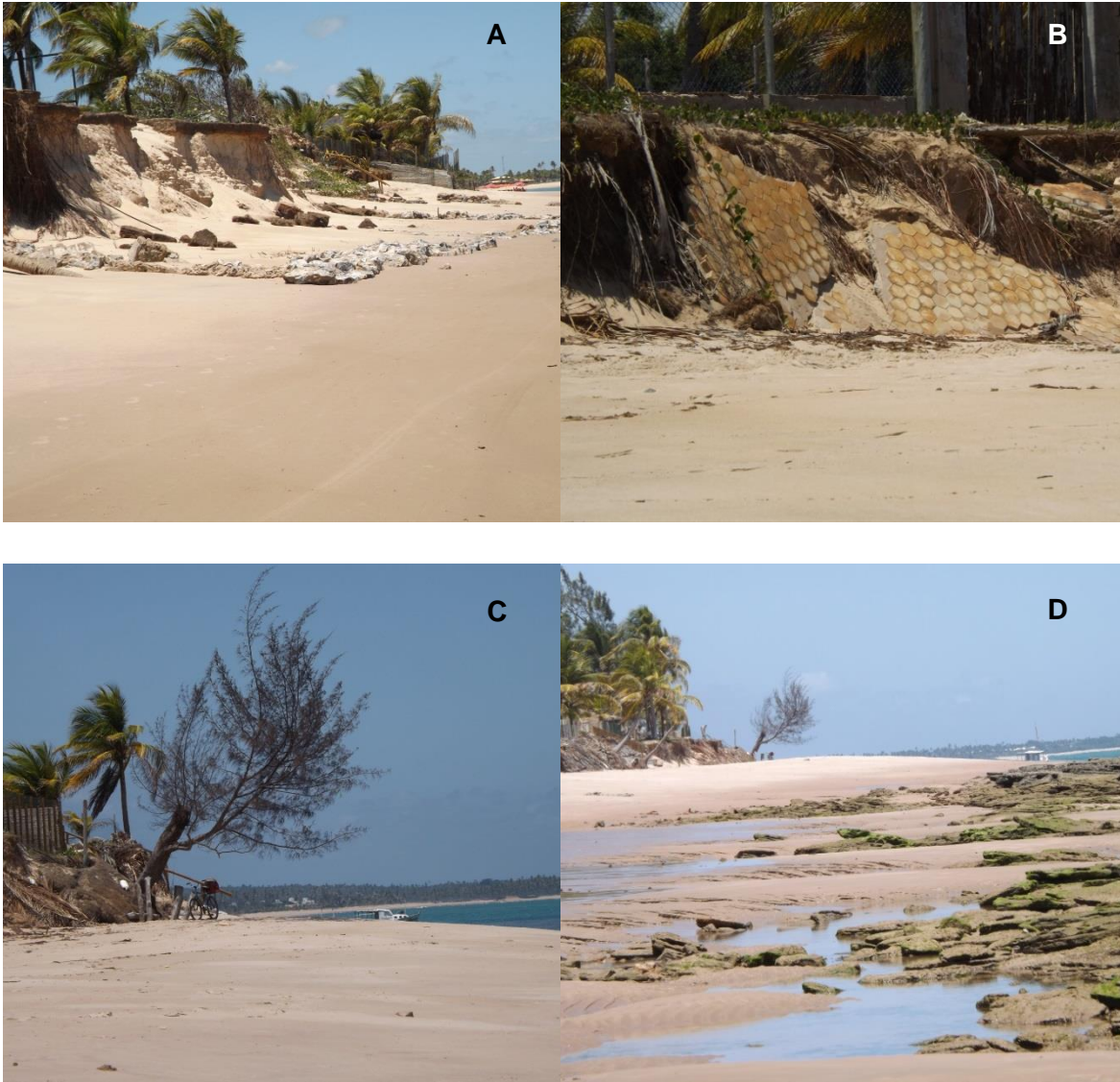
Figura 17: Trecho entre a Itacimirim e Guarajuba. A e B – Construção destruída. C – Árvores caídas e escarpa erosiva. D- Arenito de praia.
