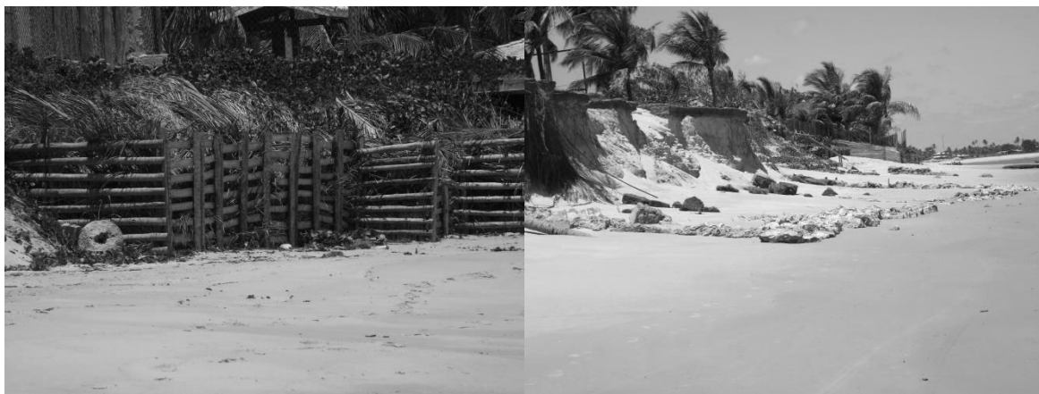
Figura 4: Obra de contenção contra o processo erosivo nas proximidades de Itacimirim
