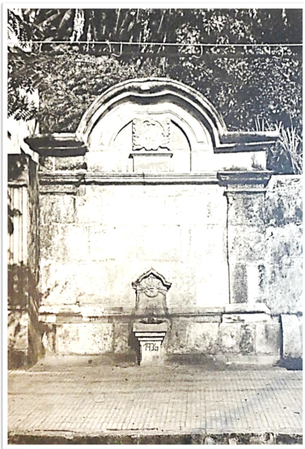
FIGURA 100- Fonte da Munganga na década de 1940. É possível detectar a formação de biofilme próximo à área do lavabo que coletava suas águas, bem como em outros pontos de seu espaldar.
