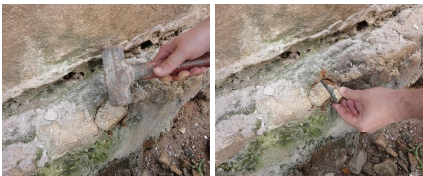
FIGURAS 25 e 26- Coleta de amostra da alvenaria de pedra para análise de teor de umidade.
