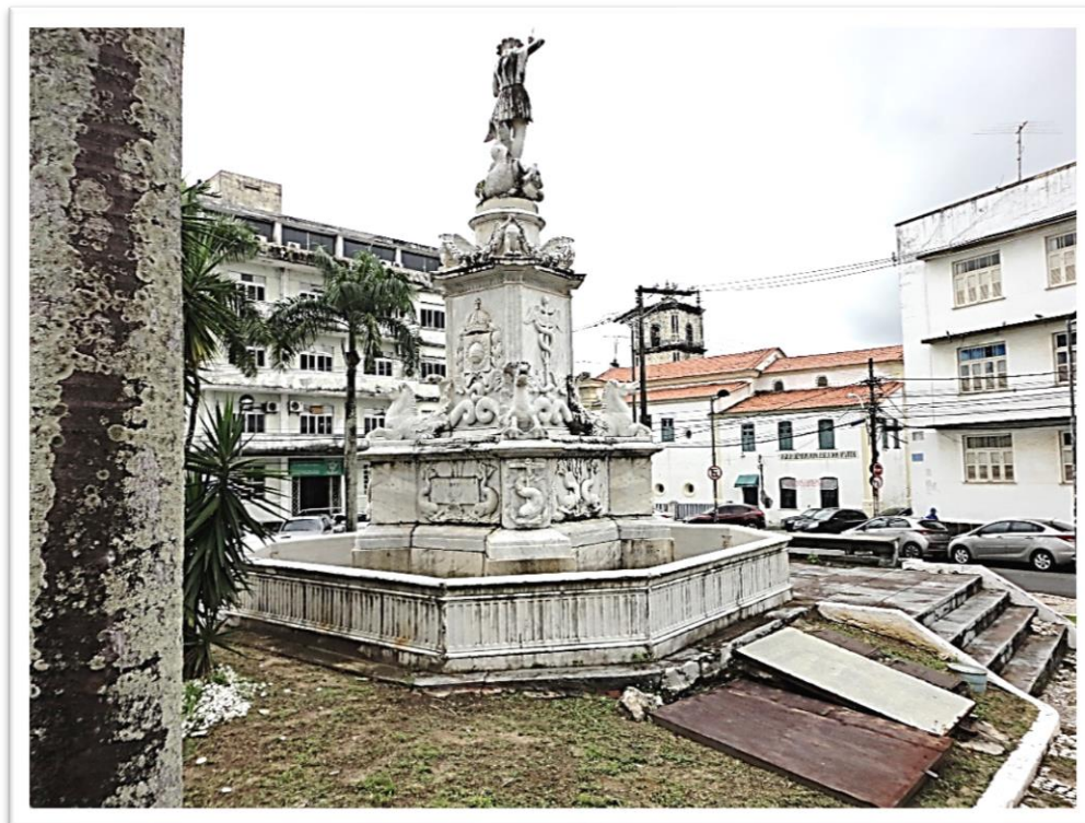
FIGURAS 124 a 126- Chafariz da Cabocla. Entorno malcuidado e acúmulo de águas pluviais e lixo na bacia de recolhimento. Formação de biofilme.
