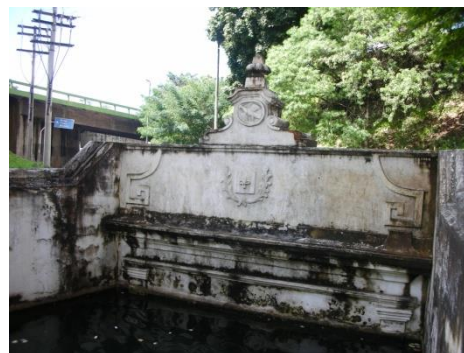
Vista do frontispício e da bacia de represamento de água.
