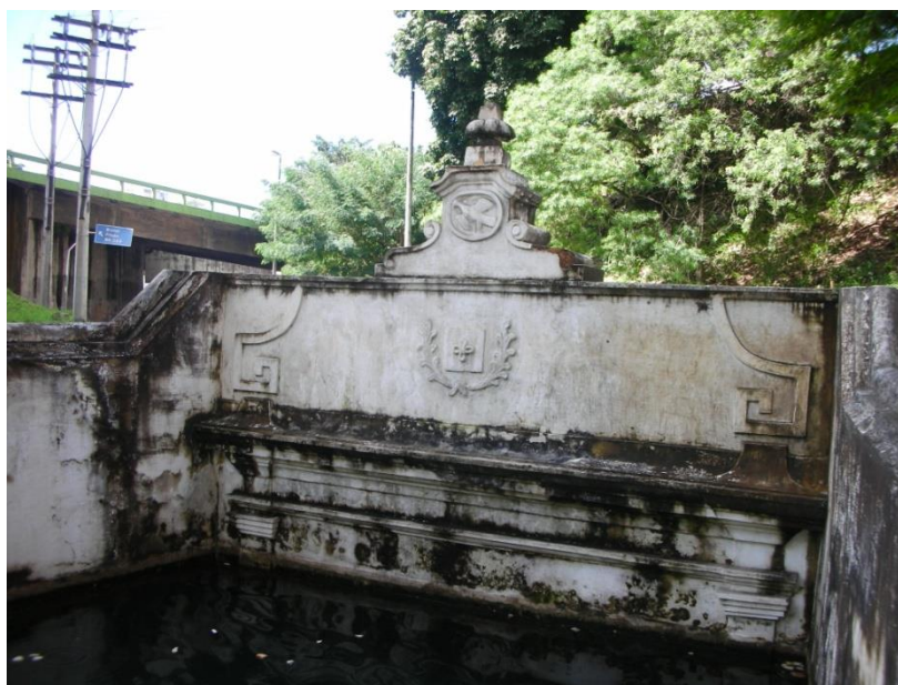
FIGURA 15- A umidade ascendente proveniente da bacia de recolhimento de águas servidas contribui para a formação do biofilme que mancha os muros da Fonte das Pedras e compromete a leitura formal do monumento. Se compararmos esta figura com a figura 11 (foto tirada em 2007) vemos a evolução considerável do biofilme.
