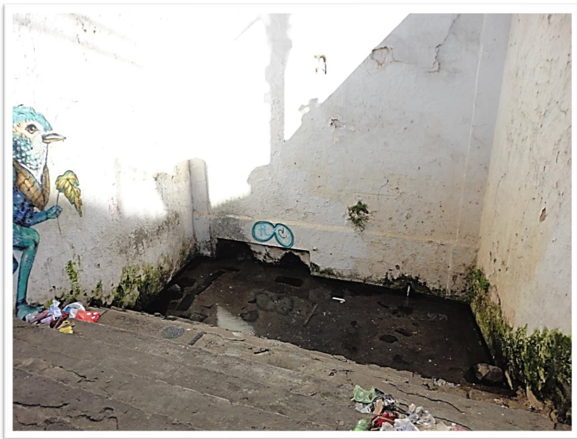
FIGURA 99- Recinto da Fonte do Gravatá. Poluição da água e acúmulo de lixo.
