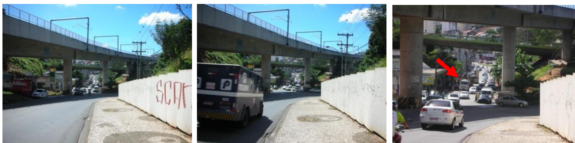
FIGURAS 2,3 e 4- Sequência de vistas da Ladeira da Fonte das Pedras no sentido descendente. A Fonte das Pedras (indicada pela seta na foto 4) praticamente invisível na composição do espaço. A predominância visual dos pilares de sustentação do elevado do futuro metrô neutraliza a fonte como signo. O tapume próximo indica as obras de construção da monumental arena de esportes para a Copa de 2014.
