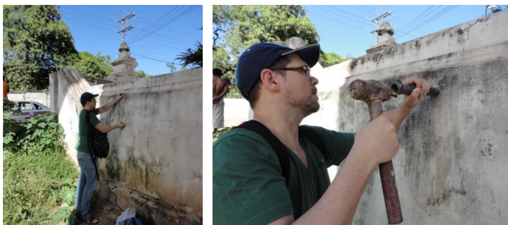
FIGURAS 21 e 22- Marcação dos pontos de coleta das amostras de argamassa no muro selecionado, e utilização do extrator e da marreta.
