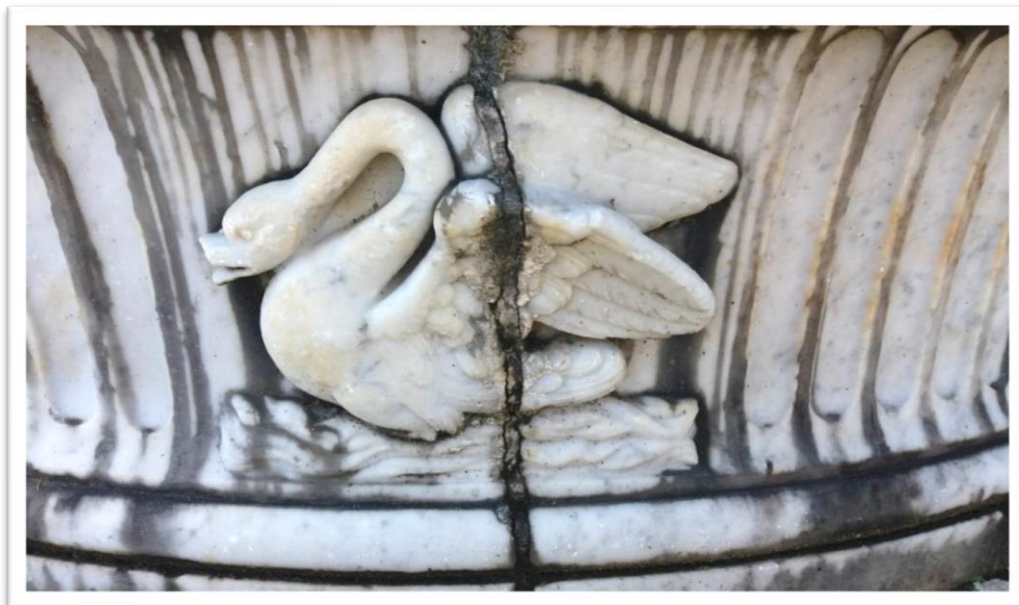
FIGURAS 131 e 132- Chafariz do Passeio Público. Crosta negra e problemas estruturais na bacia de recolhimento de águas em mármore. Perdas e junções de partes mal executadas.
