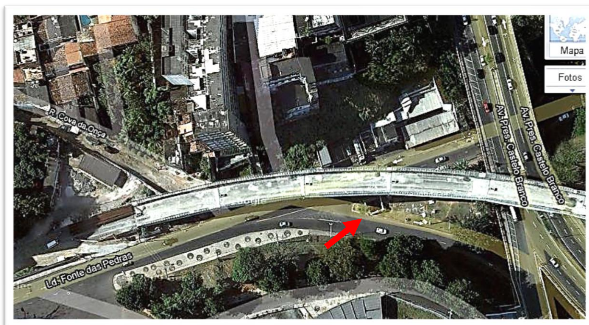
FIGURA 84- Localização da Fonte das Pedras no seu entorno atual. Dominando a paisagem, o elevado do metrô de Salvador, ainda em construção neste momento.
