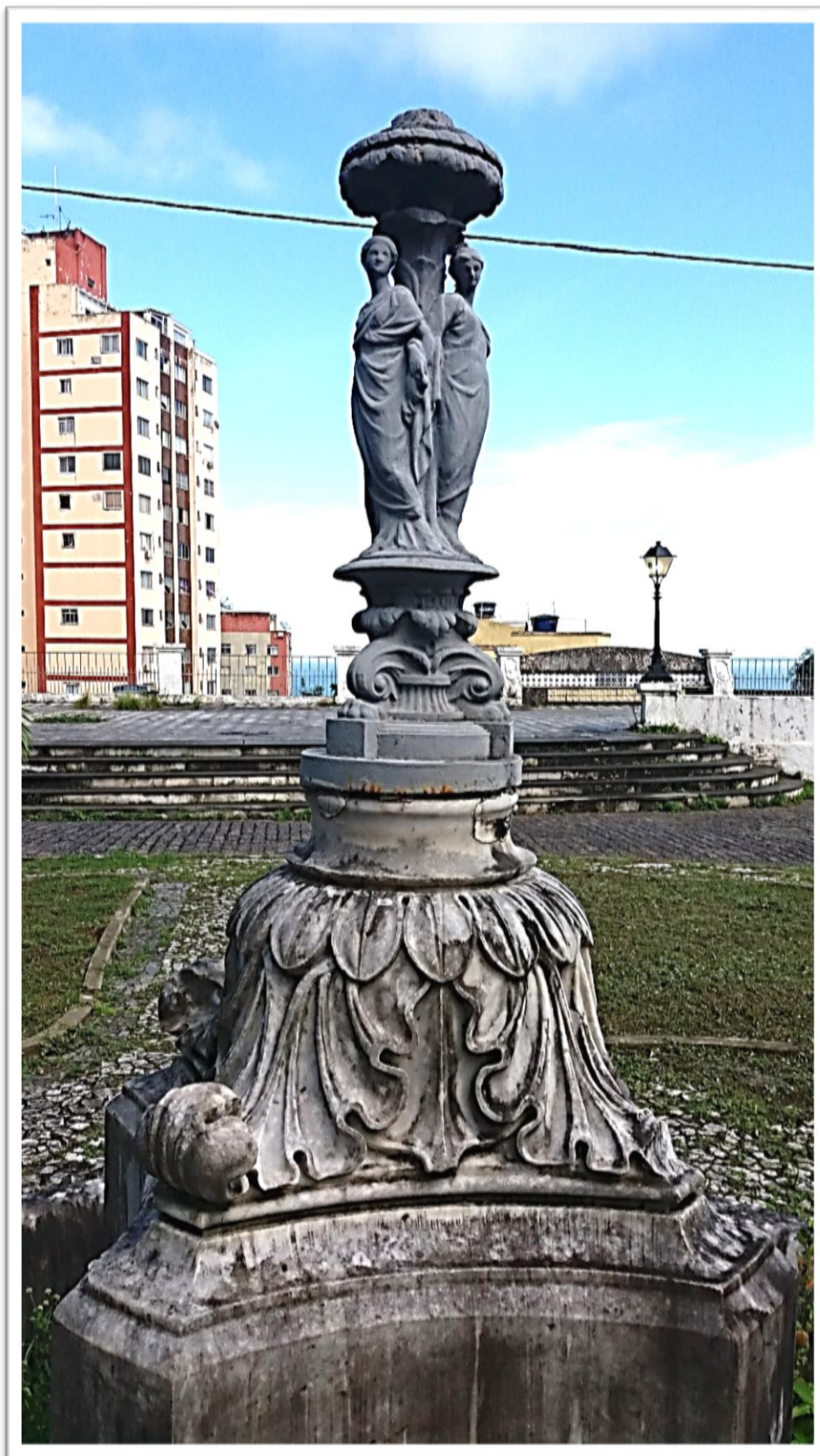
FIGURA 130- Chafariz do Passeio Público. Oxidação e desgaste do esguicho em bronze. Abrasões e crosta negra na base em mármore.
