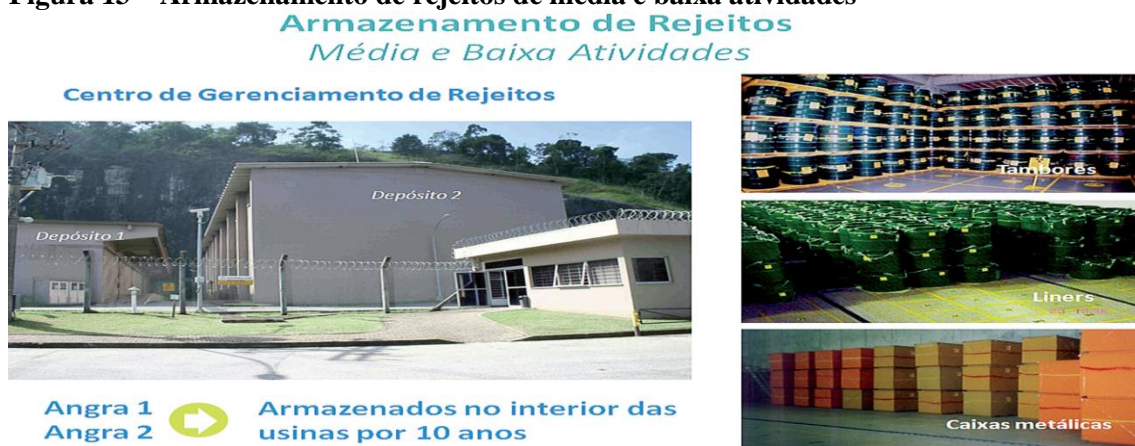
Figura 13 – Armazenamento de rejeitos de média e baixa atividades
