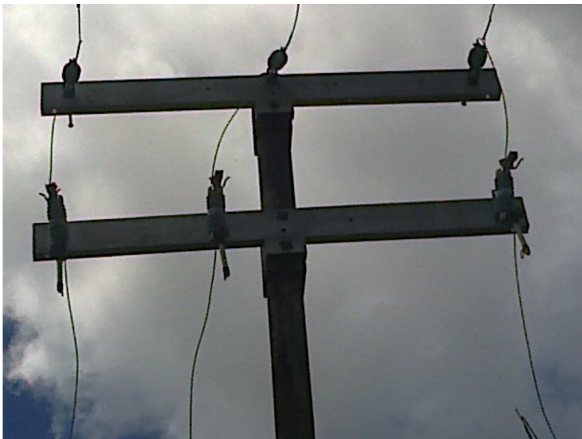
Figura 3.1 Chave fusível com elos abertos
