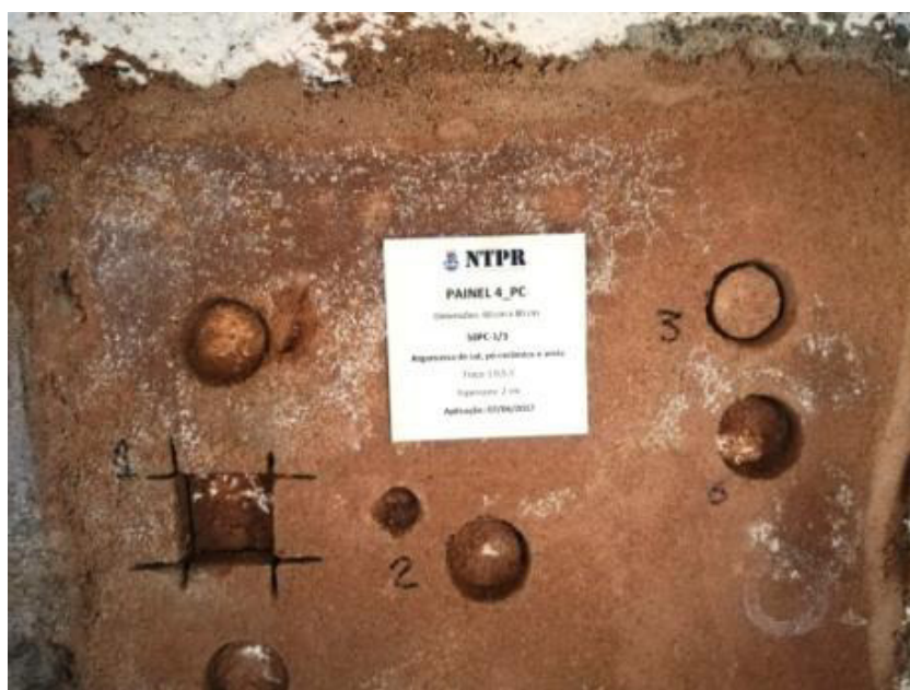
Figura 75 – Pormenor do painel argamassa de pó cerâmico, aos 6 meses
