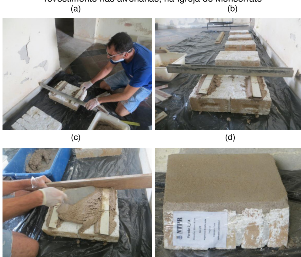
Figura 42 (a, b, c, d) – Sequência de operações para aplicação de argamassas de revestimento nas alvenarias, na Igreja de Monserrate
