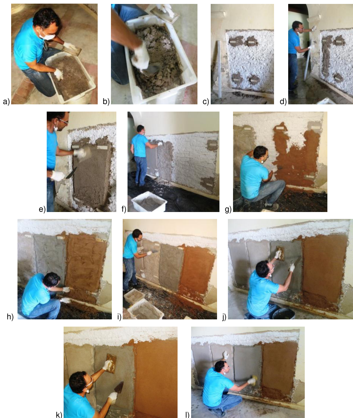
Figura 40 (a até l) – Sequência de operações para execução e aplicação de argamassas de revestimento estudadas, na Igreja de Monserrate
