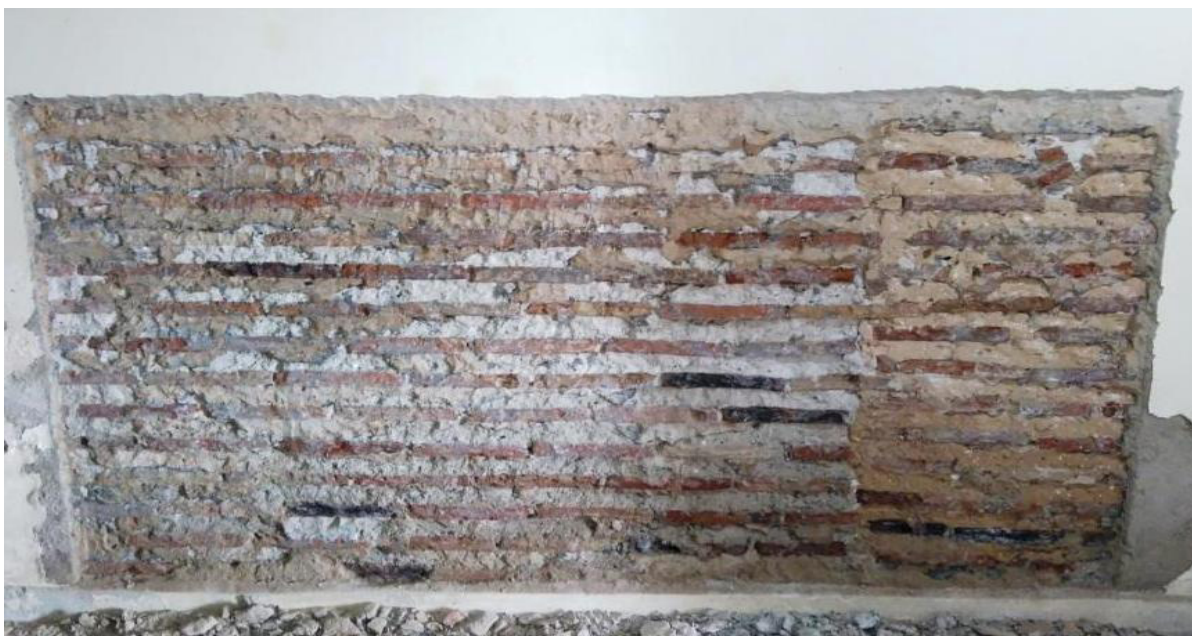
Figura 38 – Alvenaria da Igreja de Monserrate após remoção do revestimento
