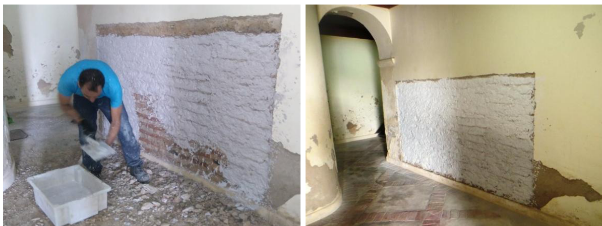
Figura 39 (a, b) – Aspecto final da alvenaria depois da aplicação do chapisco
