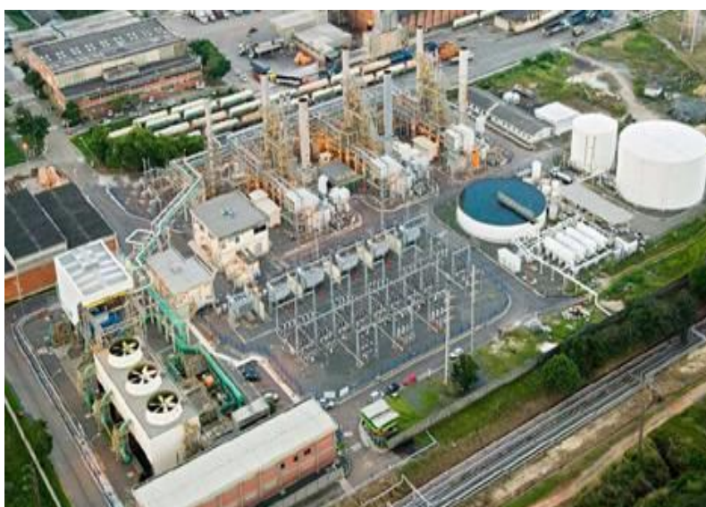
Figura 13 – Termelétrica Rômulo Almeida (SÁ BARRETTO, 2009).
