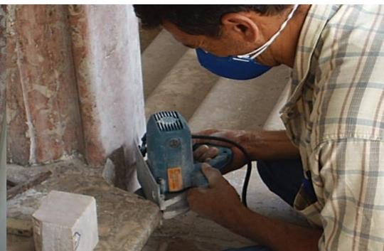
Figura 181 – Colocação da parte faltante usando pedra lioz
