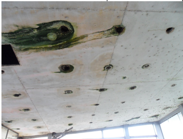
Figura 65 Forro sob cobertura do último pavimento do Pavilhão Popular.
