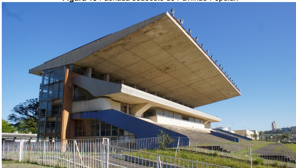
Figura 19 Fachada sudoeste do Pavilhão Popular.
