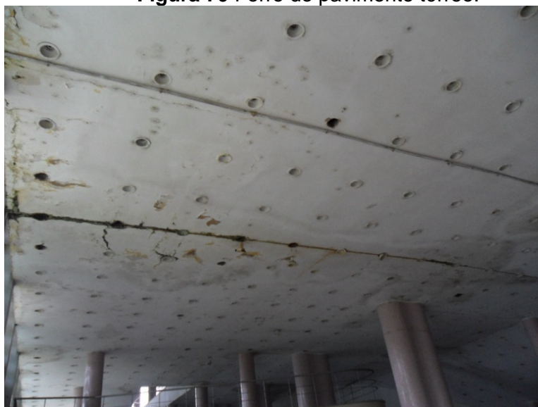
Figura 70 Forro do pavimento térreo.
