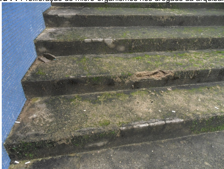
Figura 71 Proliferação de micro-organismos nos dregaus da arquibancada.
