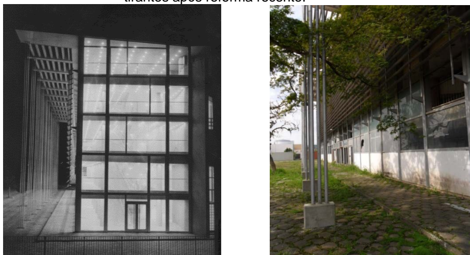
Figura 25 Na esquerda fotografia do Pavilhão Popular logo após a construção, a direita fixação dos tirantes após reforma recente.
