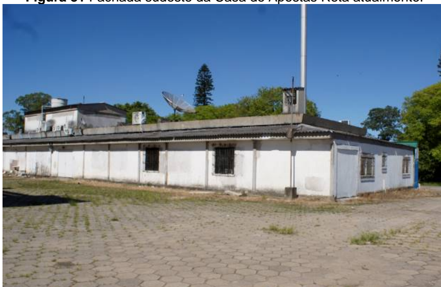
Figura 81 Fachada sudeste da Casa de Apostas Reta atualmente.
