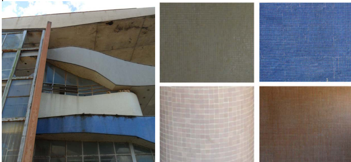
Figura 29 Fachada sudoeste do Pavilhão Popular e detalhe dos revestimentos em pastilha.
