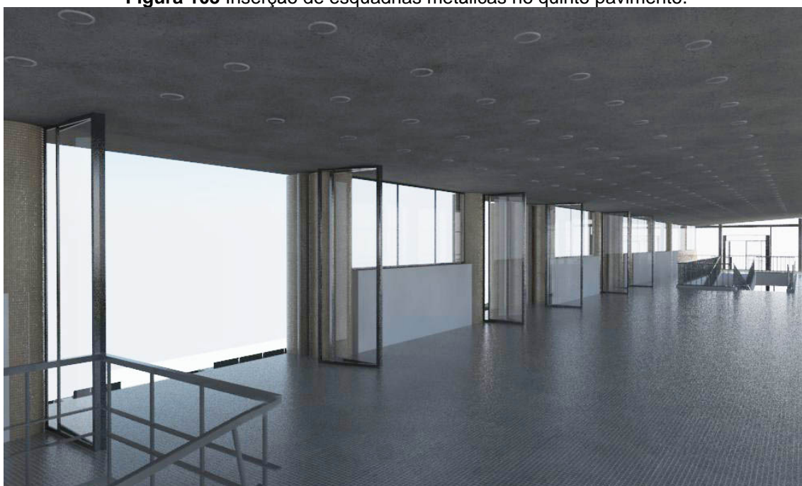
Figura 103 Inserção de esquadrias metálicas no quinto pavimento.
