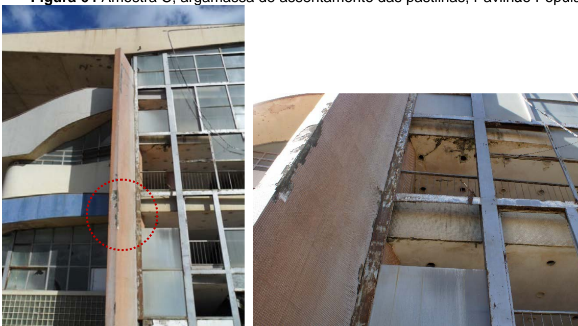
Figura 64 Amostra C, argamassa de assentamento das pastilhas, Pavilhão Popular.
