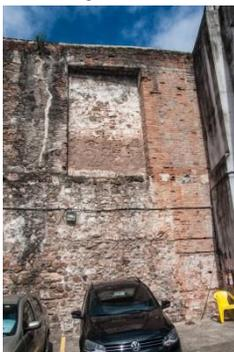
Observar o trecho em alvenaria de tijolo que foi construído para se adequar ao novo alinhamento da Avenida Jequitaia
