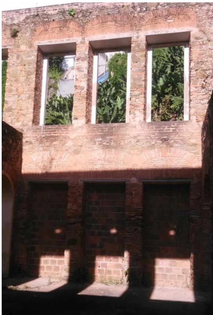
**LEGENDA:** Trecho da face interna da fachada da Rua do Pilar. Apresenta três vãos de porta fechados com bloco seis furos e no terceiro nível três janelas rasgadas.
