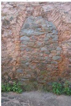
Observar a existência de um vão de porta fechado em alvenaria de pedra.
