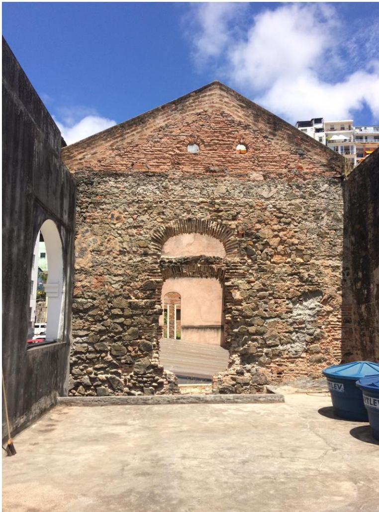
**LEGENDA:** Trecho da parede interna em alvenaria de pedra que separa os dois anexos.
