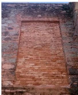
Observar que anteriormente existiam vãos de janela que foram fechados, possivelmente para se adequar a um novo desenho da fachada.
