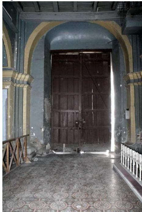
Figura 2: Vista desde la nave lateral derecha. Nótese la falta de recubrimiento en los muros de ladrillo y las manchas de agua ascendentes. También se aprecia la viga principal del entrepiso en fallo, provocando el fallo del resto de las vigas que lo conforman en este tramo.
