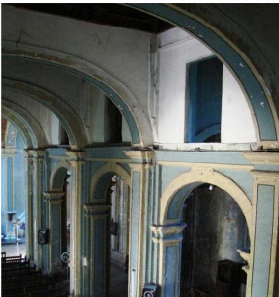
Figura 41. Muros sobre los arcos de las naves centrales con vanos para permitir la iluminación y ventilación a través de ellos. 2010. Fuente: Archivo de la Oficina del Conservador de la Ciudad. Fotógrafo: Francisco Montes de Oca.
