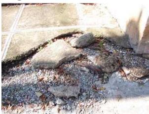
Figura 3: Desconches, pérdida de revoco, material expuesto, causado por la humedad acresentada por los árboles que impiden el asoleamiento. Presencia de costra negra en basamento y cornisas.
