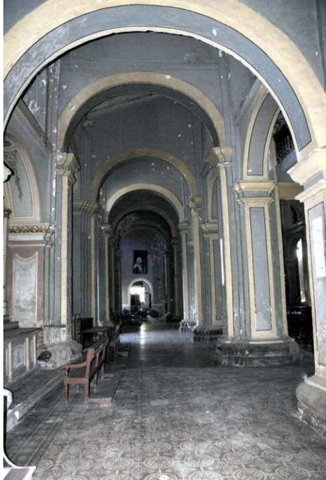
Figuras 3: Puerta de acceso al pasillo lateral y al patio interior. Pueden verse los muros sobre los arcos y las aberturas en los mismos para facilitar la iluminación y ventilación de las naves. También se aprecia la estructura de cubierta de madera a vista entre las aberturas del muro.
