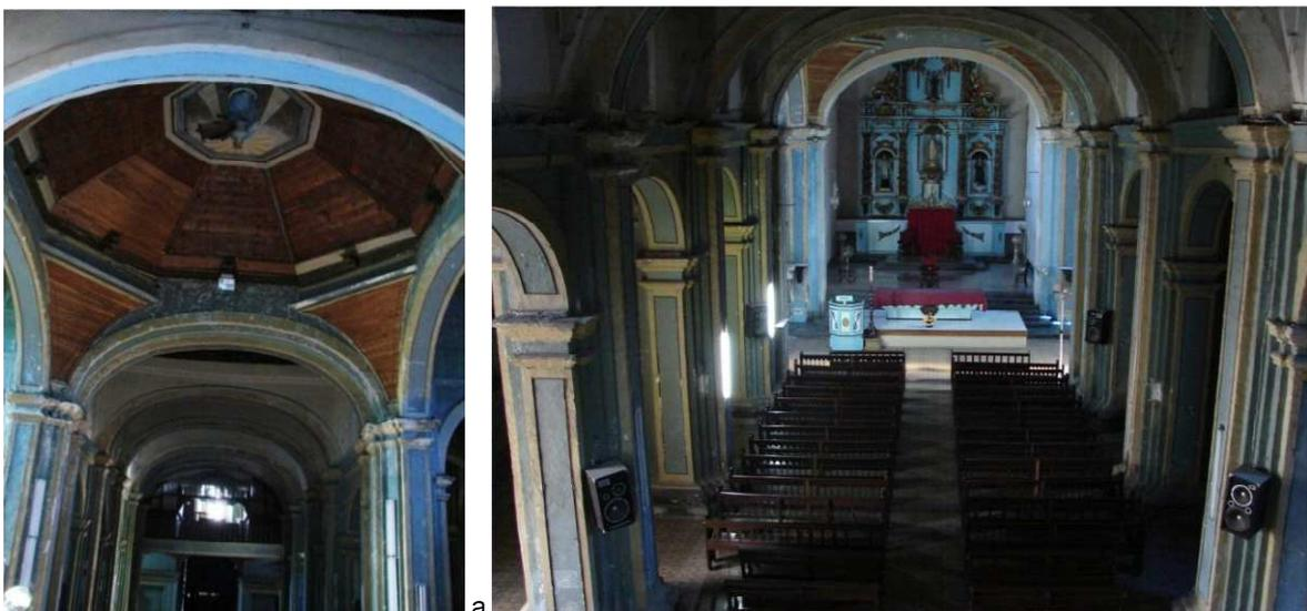
Figura 46. Cúpula de la nave crucero.2010 Figura 46 b. Sistemas de pórticos con arcos y pilares de ladrillo. 2010. Fuente: Archivo de la Oficina del Conservador de la Ciudad. Fotógrafo: Francisco Montes de Oca.
