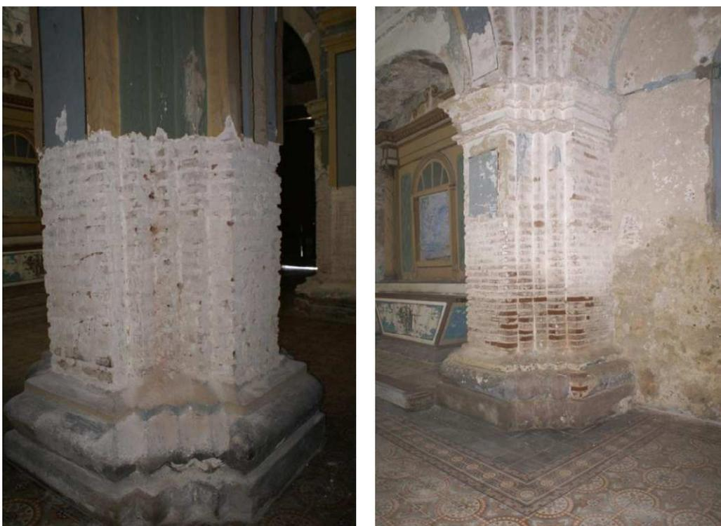
Figura 42. Estructura de ladrillo de las columnas, pilares y arcos. Septiembre 2016. Fuente: Archivo de la Oficina del Conservador de la Ciudad. Fotógrafo: Francisco Montes de Oca.
