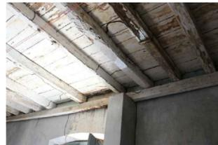
Algumas peças do barroteamento do corredor noroeste já sofrem intervenções, como substituição de partes e junções com novas peças
