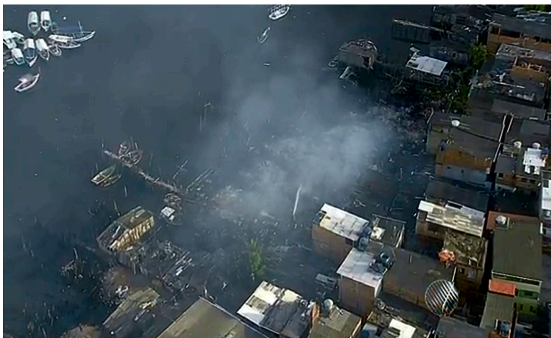
Figura 26 - Vista aérea do local do incêndio. Fonte: Band News, acesso em 20/01/2015
