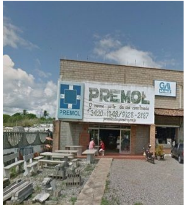
Figura 3.2b- Fachada frontal da fábrica de pré-moldados
