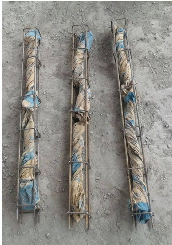
Figura 3.9 – Embalagens retorcidas introduzidas nas armaduras
