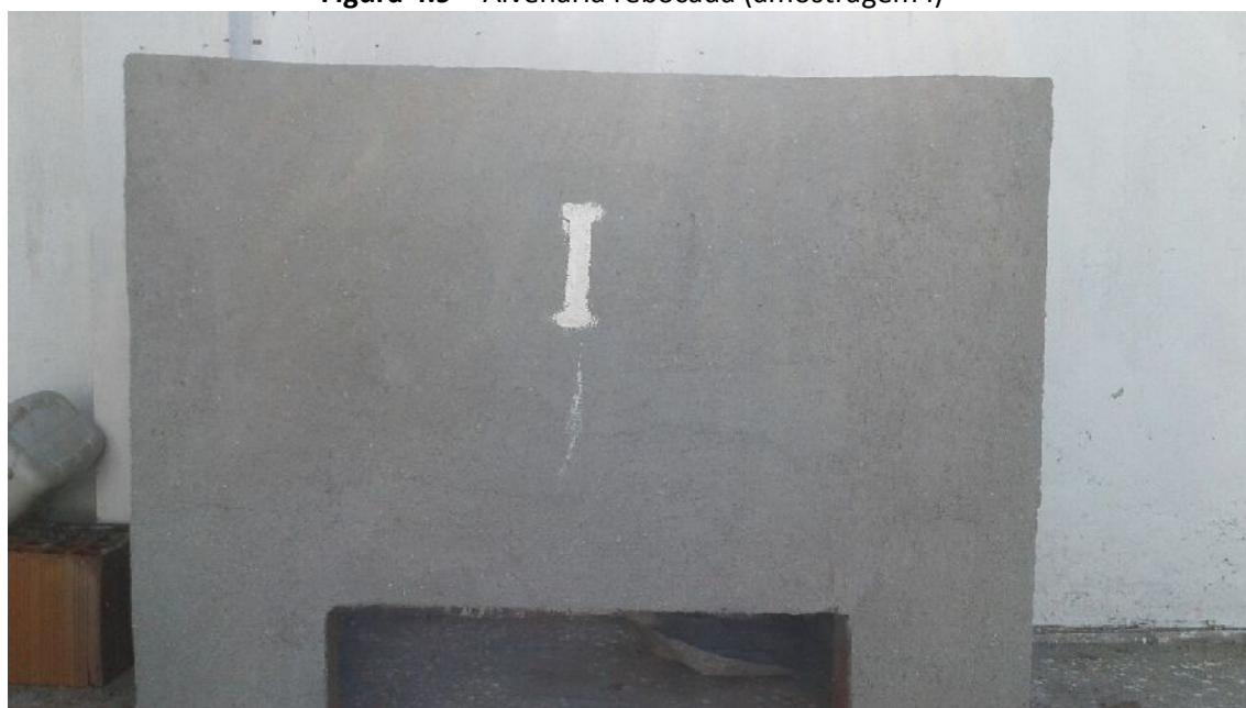
Figura 4.9 – Alvenaria rebocada (amostragem I)
