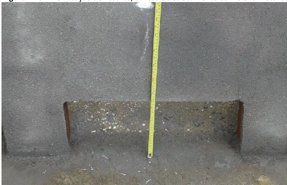
Figura 4.15 – Verificação de fissuras, trincas e deslocamento com trena metálica
