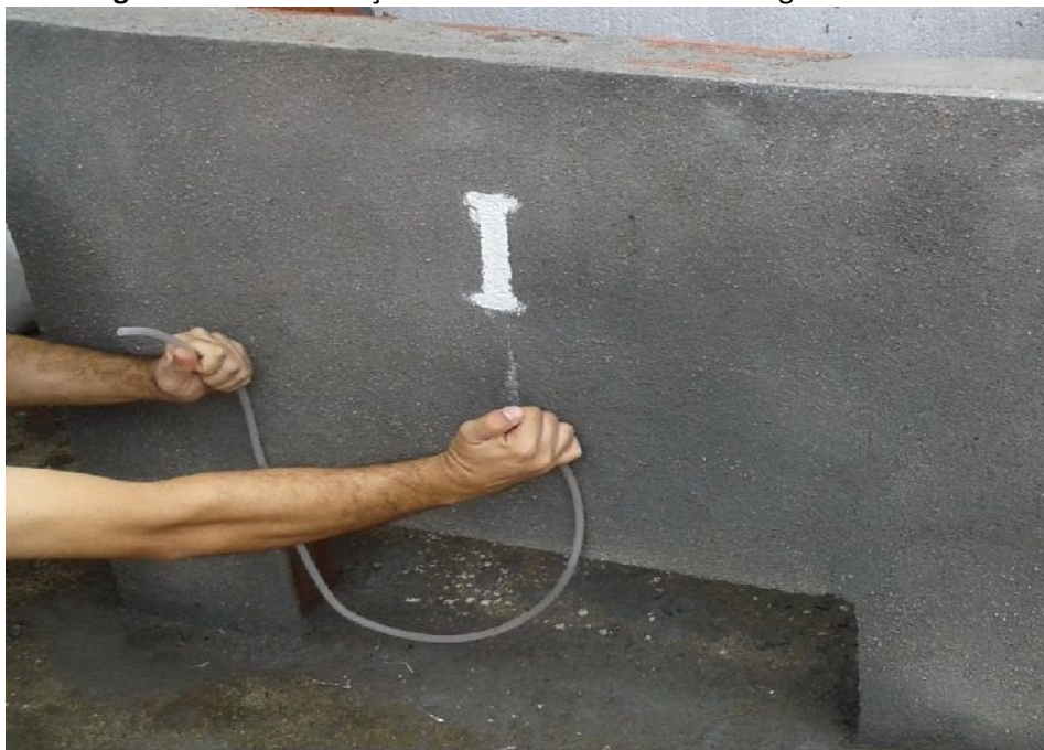
Figura 4.14 – Verificação de deslocamento com mangueira de nível
