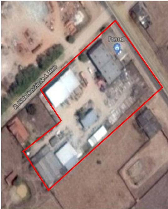
Figura 3.2a- Fábrica de pré-moldados na cidade de Palmeira dos Índios-AL (por satélite)
