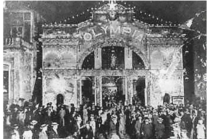
Fachada do Cinema Olímpia (Rua Visconde de Rio Branco, 53, RJ). “Com iluminação feérica, lembrando mais um circo que propriamente um cinema”.
