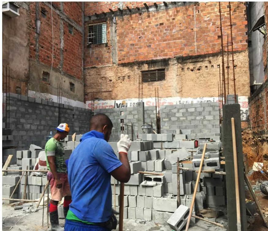
Figura 25 – Construção de creche comunitária por iniciativa local, 2017
