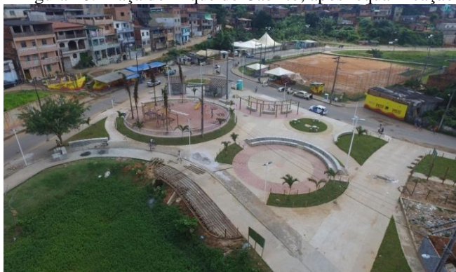
Figura 28. Praça do Dique do Cabrito, após requalificação.
