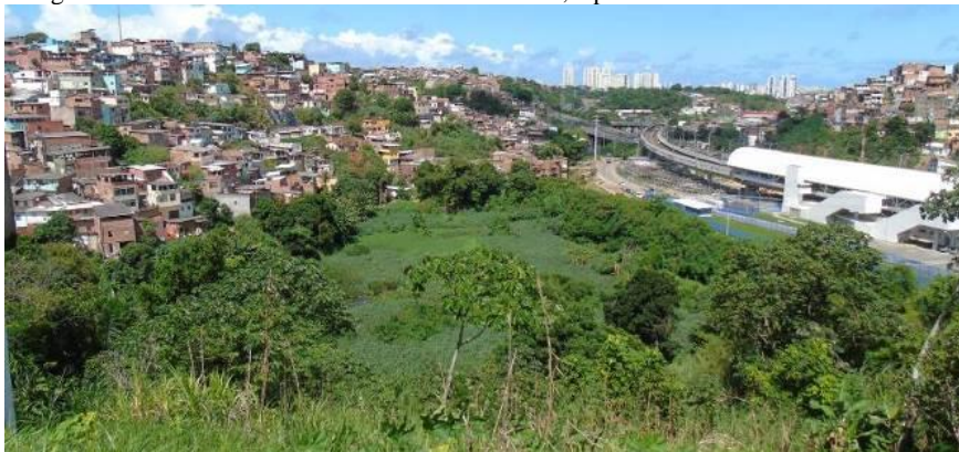
Figura 6. Registro da conexão entre o Metrô e a comunidade, a partir da encosta do bairro da Mata Escura.
