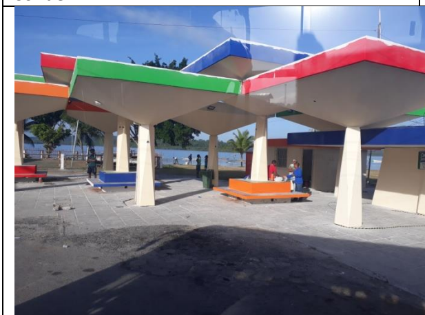
Foto 5: Terminal Rodoviário de São Francisco do Conde
