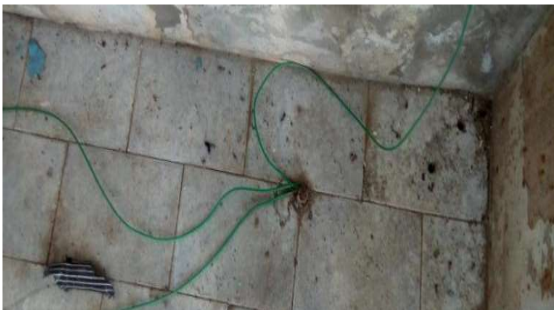
Figura 28: Aterramento do estabelecimento (vista aproximada de um dos pontos).
