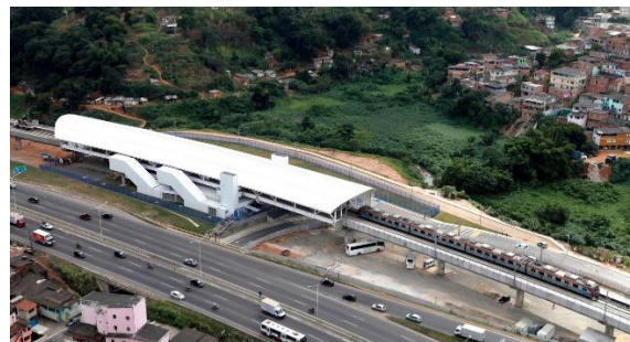
Figura 44. F 5 Vista Estação de Metrô e Represa M. Escura
