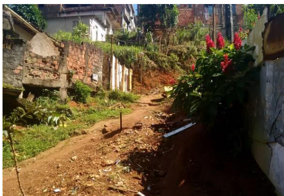
Figura 25. Registro ao entorno da Ladeira da Bica, onde se observa trecho desta.
