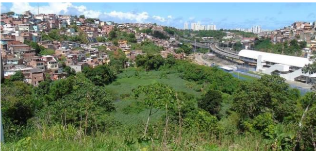
Figura 4. Registro da conexão entre o Metrô e a comunidade, a partir da encosta do bairro da Mata Escura.
