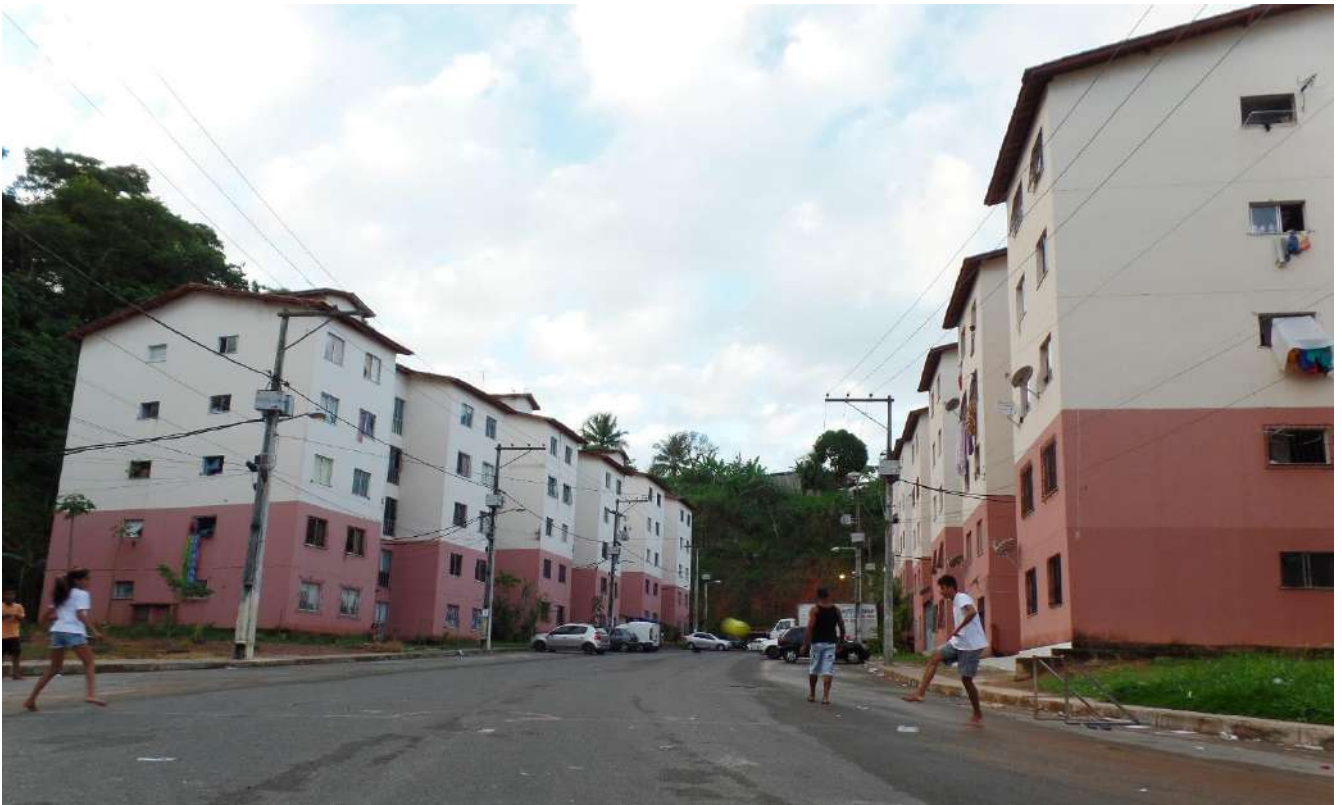
Figura 12 - Visão parcial do Setor C
