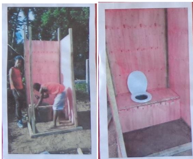
Figura 29: Montagem do banheiro seco.
