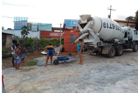
Figura 26: Caminhão do concreto descartando o “bota-fora”
