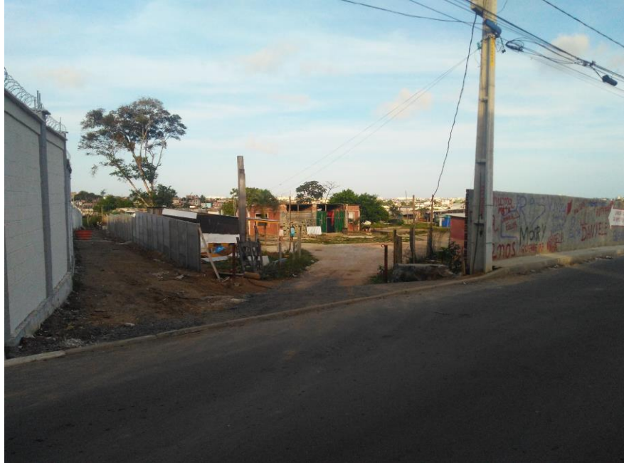
Figura 39: Muros Construídos na parte lateral e frontal do terreno.
