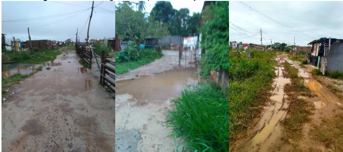
Figura 23: Áreas alagadas e impermeabilização do solo com uso de concreto.
