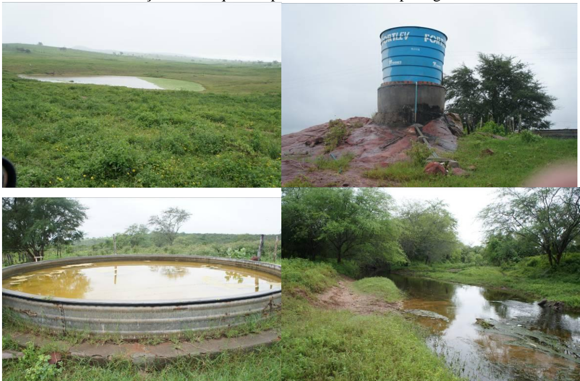
Figura 9 – Infraestrutura de fornecimento de água na Fazenda I, composta por um ponto de captação direta do rio e dois poços artesianos que distribuem a água para diversos açudes e tanques dispersos nas áreas de pastagem
