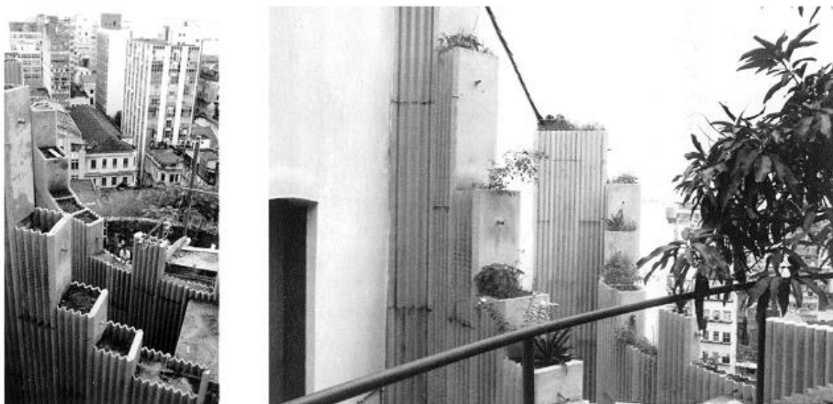
Fig. 16 - Montagem dos contrafortes coroados com a vegetação arbustiva das 'jardineiras' nos respaldos
