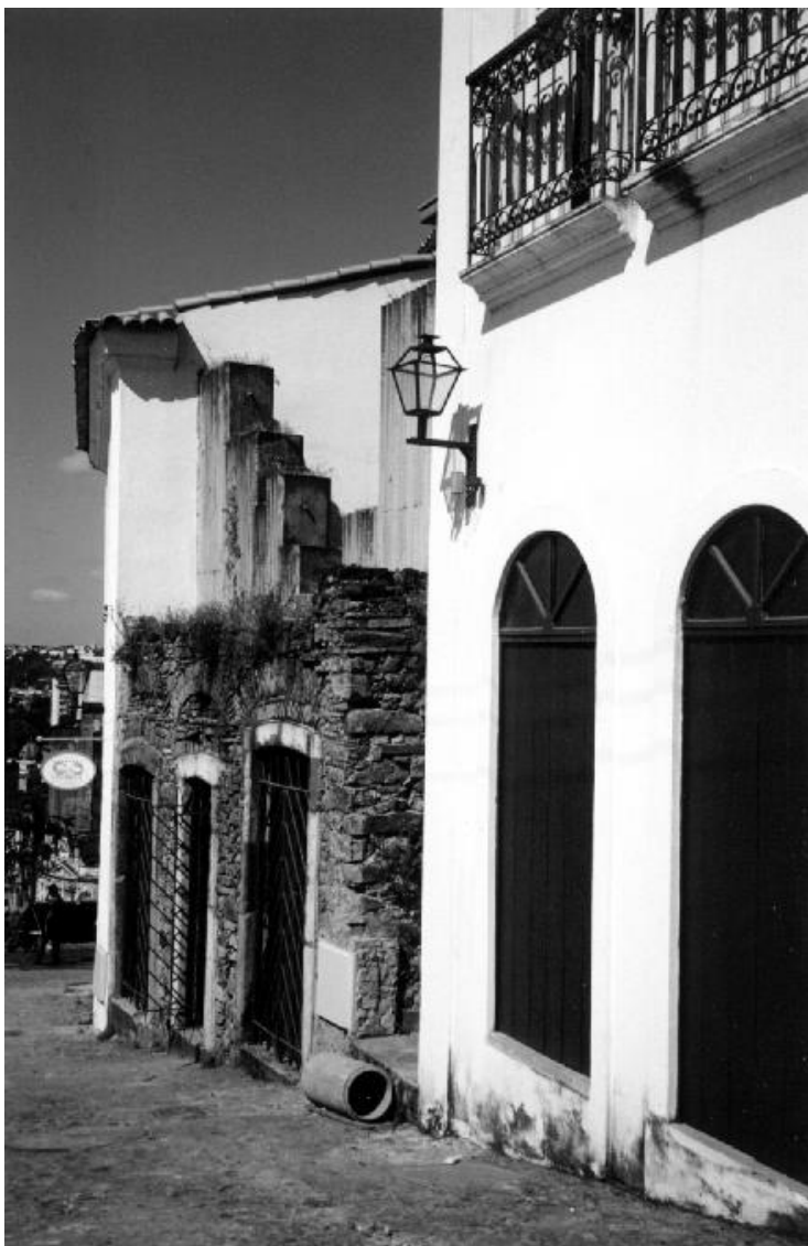
Fig. 29 - Esquadrias do sobrado e do Bar dos 3 Arcos pintadas com o verde SPHAN
