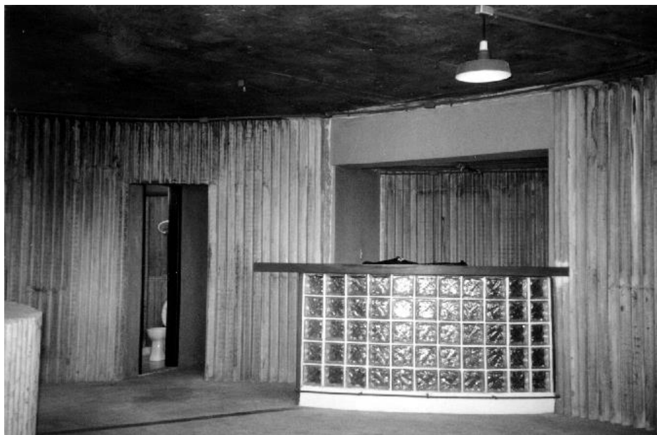
Fig. 26 - Novo balcão decorativo construído na reforma
