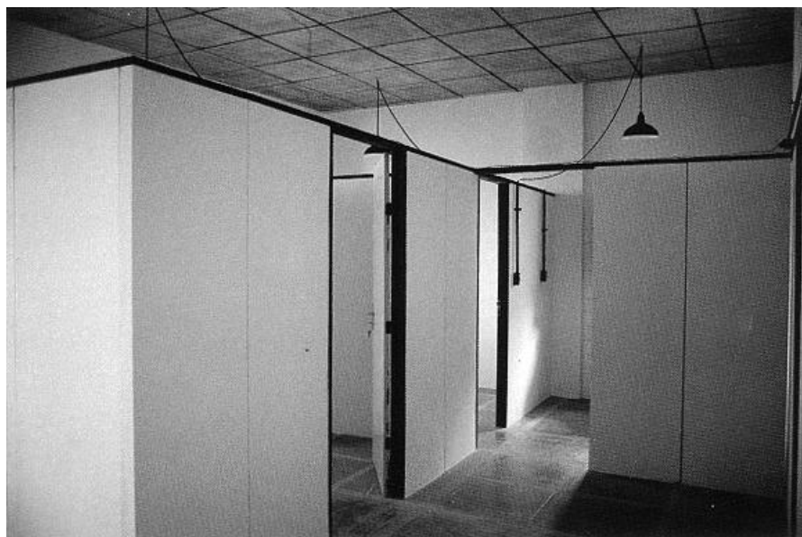
Fig. 18 - Aspecto dos interiores recuperados, divisórias, piso e instalações
