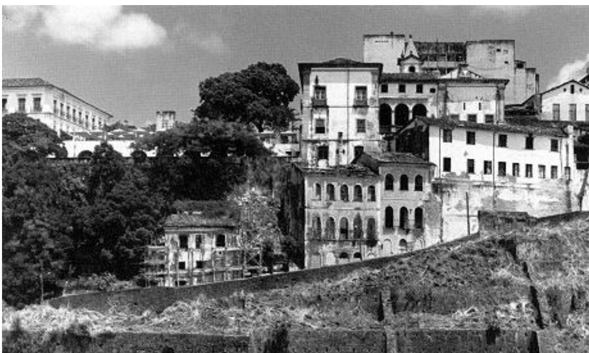
Fig. 09 - Vista do estado de conservação do casario da ladeira, em 1986
