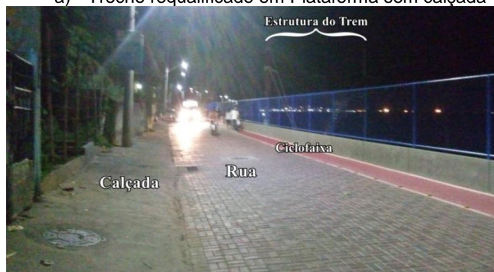
b) Trecho requalificado em Plataforma com calçada
