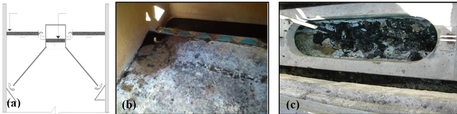
Figura 6.4 – (a) Identificação dos pontos de acumulação de espuma em reatores UASB; (b) espuma na superfície do decantador; (c) espuma no interior do separador trifásico
