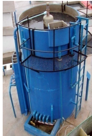
Figura 4.14 – Ilustrações esquemáticas de reatores UASB cilíndricos
