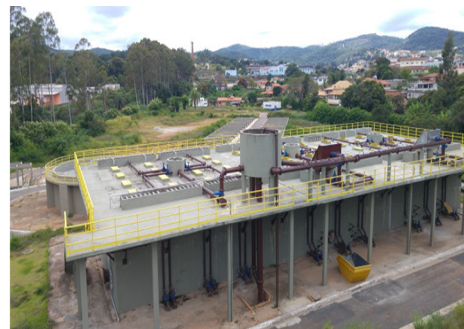
Figura 4.15 – Ilustrações esquemáticas reatores UASB prismáticos retangulares
