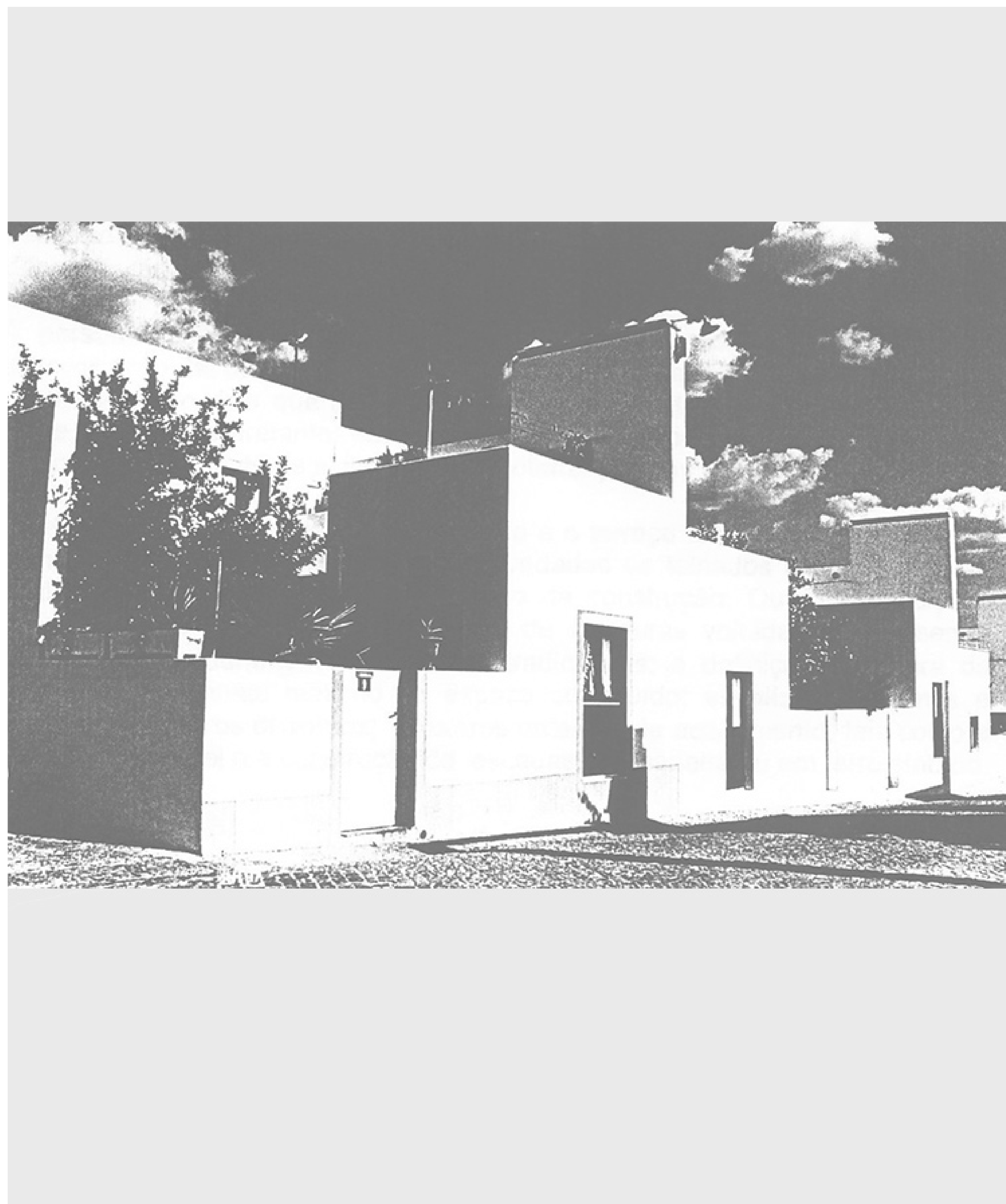
figura 04 – Unidade Habitacional: Notar aberturas, vegetação no pátio, e detalhe de azulejaria. Foto: autor.
