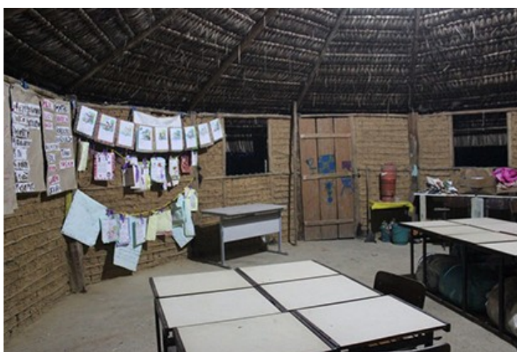
Figuras 1.15 e 1.16. Anexo Tucum (sede: CEITO). Construção provisória. Por Nathalie Pavelic, 5 fev. 2018.
