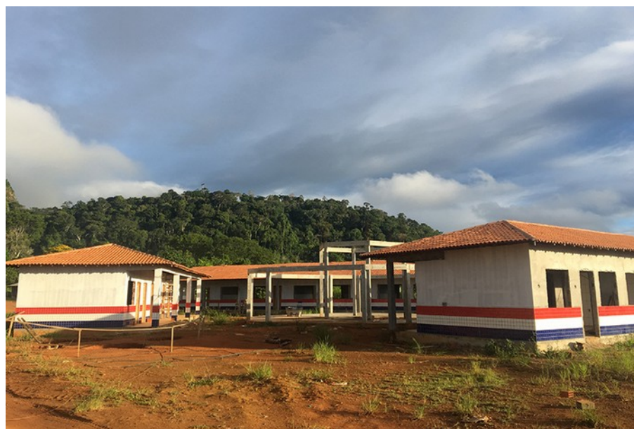
Figura 2.2. Estado da obra do CEITSP. Por Nathalie Pavelic, abr. 2019.
