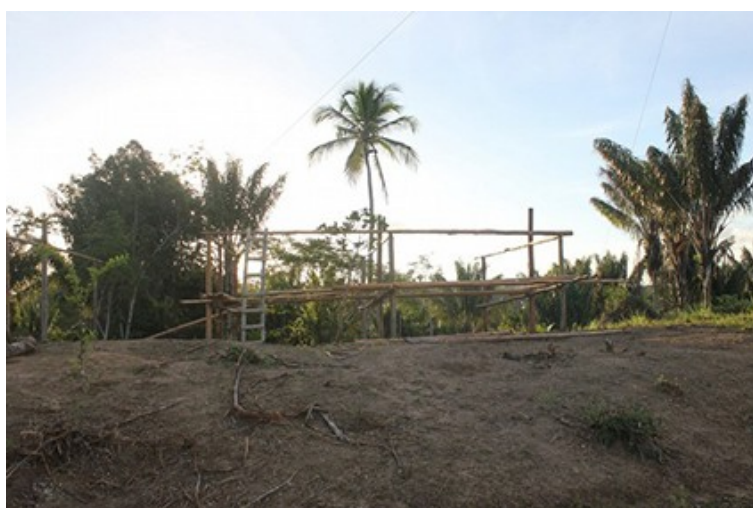
Figura 1.39. Anexo Acuípe do Meio 2 em construção (2018). Por Nathalie Pavelic, 17 fev. 2018.
