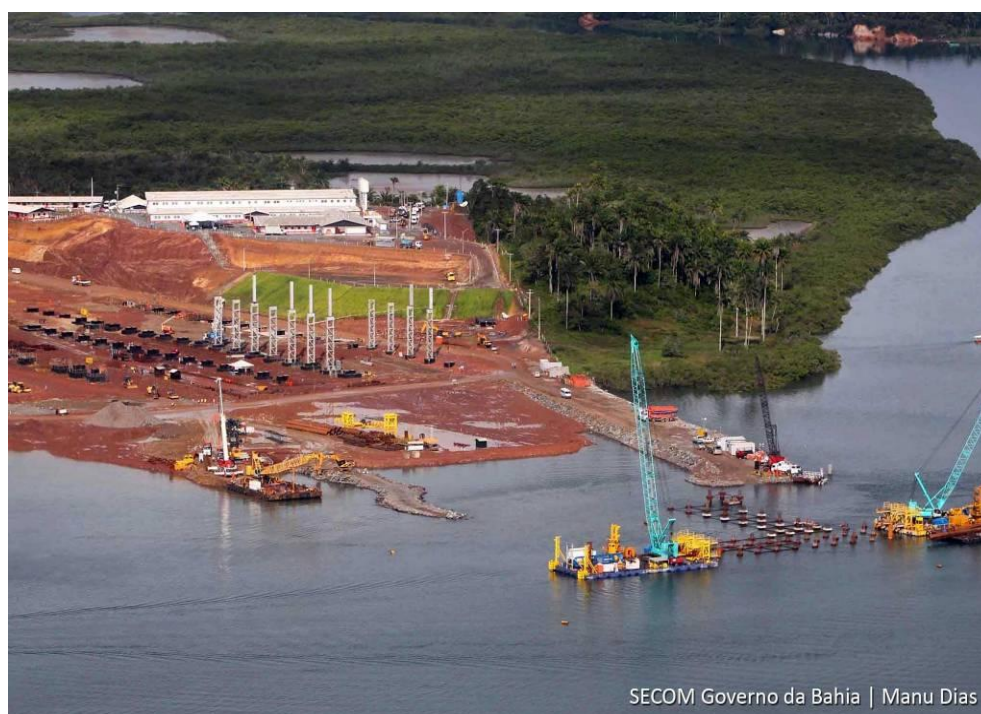
Figura 13: Imagem da construção do Estaleiro EEP
