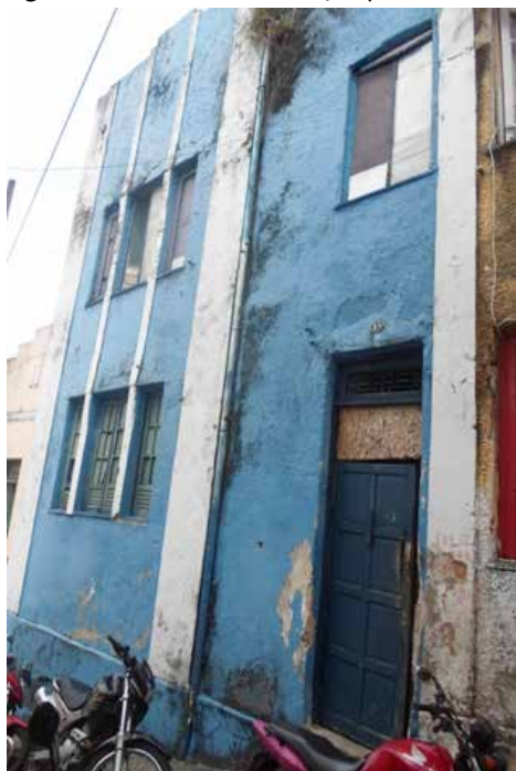
Figura 98 – Prédio da relocação provisória de Dona Di, no Beco do Seminário
