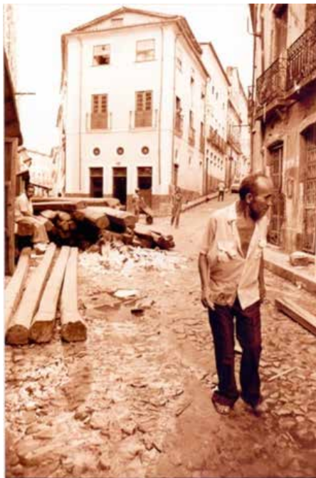
Figura 91 – Prédios reformados e não reformados no Maciel
