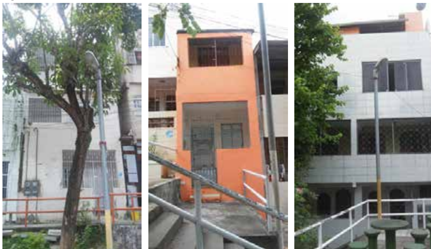
Figura 39 – Casas do Beco da Bota de Ouro
