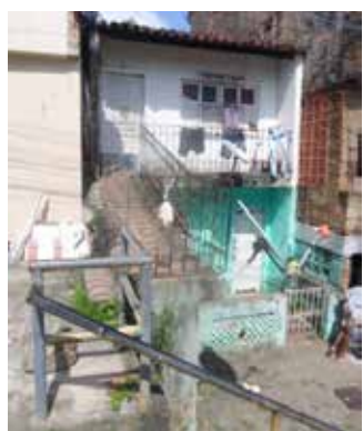
Figura 68 – Incorporação de uma escada externa
