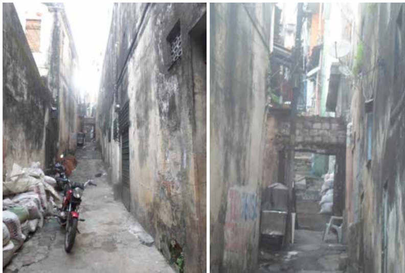
Figura 57 – Entrada da Avenida Camponesa
