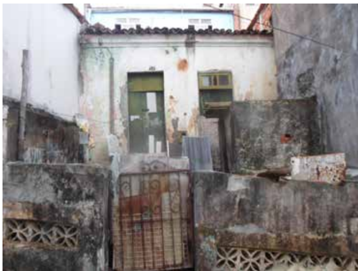
Figura 49 – Casa de porta e janela, com estrutura próxima à original
