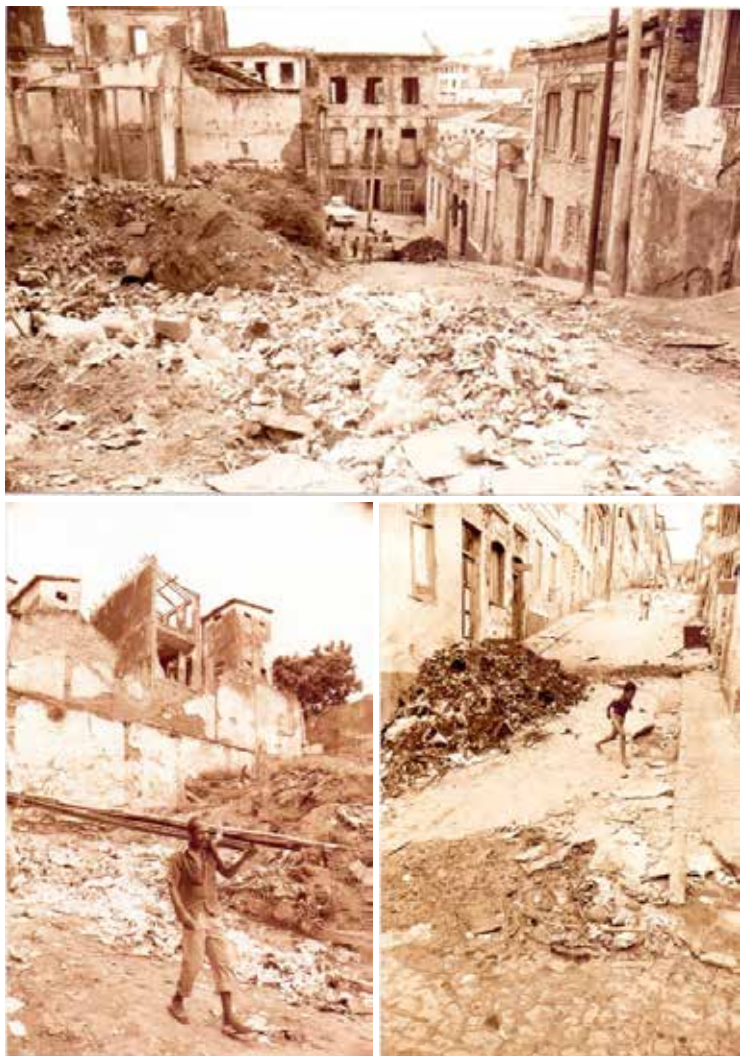
Figura 92 – Ruínas e escombros no Maciel. Beco do Mijo (Rua Inácio Accioly)
