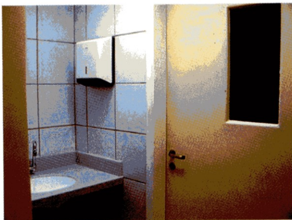
Foto 17. Porta de quarto de isolamento
