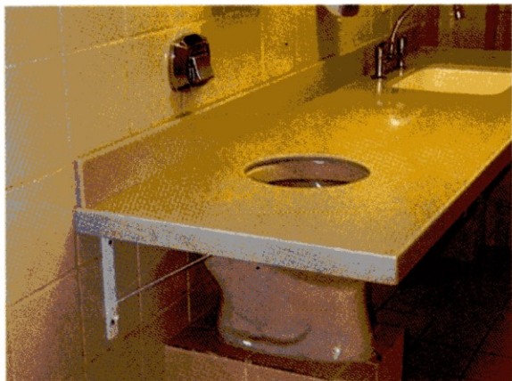
Foto 10. Pia integrada à bancada com pia de expurgo
