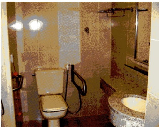
Fotos 20 e 21. Banheiros com barras de apoio
