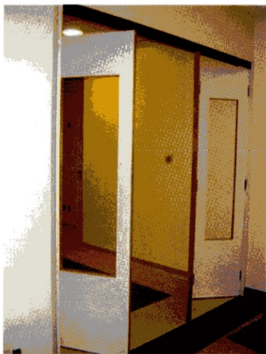
Foto 18. Porta sanfonada. Permite a abertura total do vão
