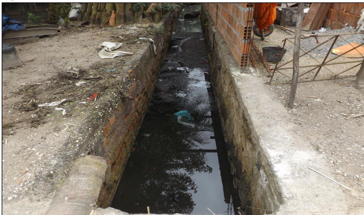
Figura 11 – Vala a céu aberto em Praia Grande, Ilha de Maré, Salvador-BA.
