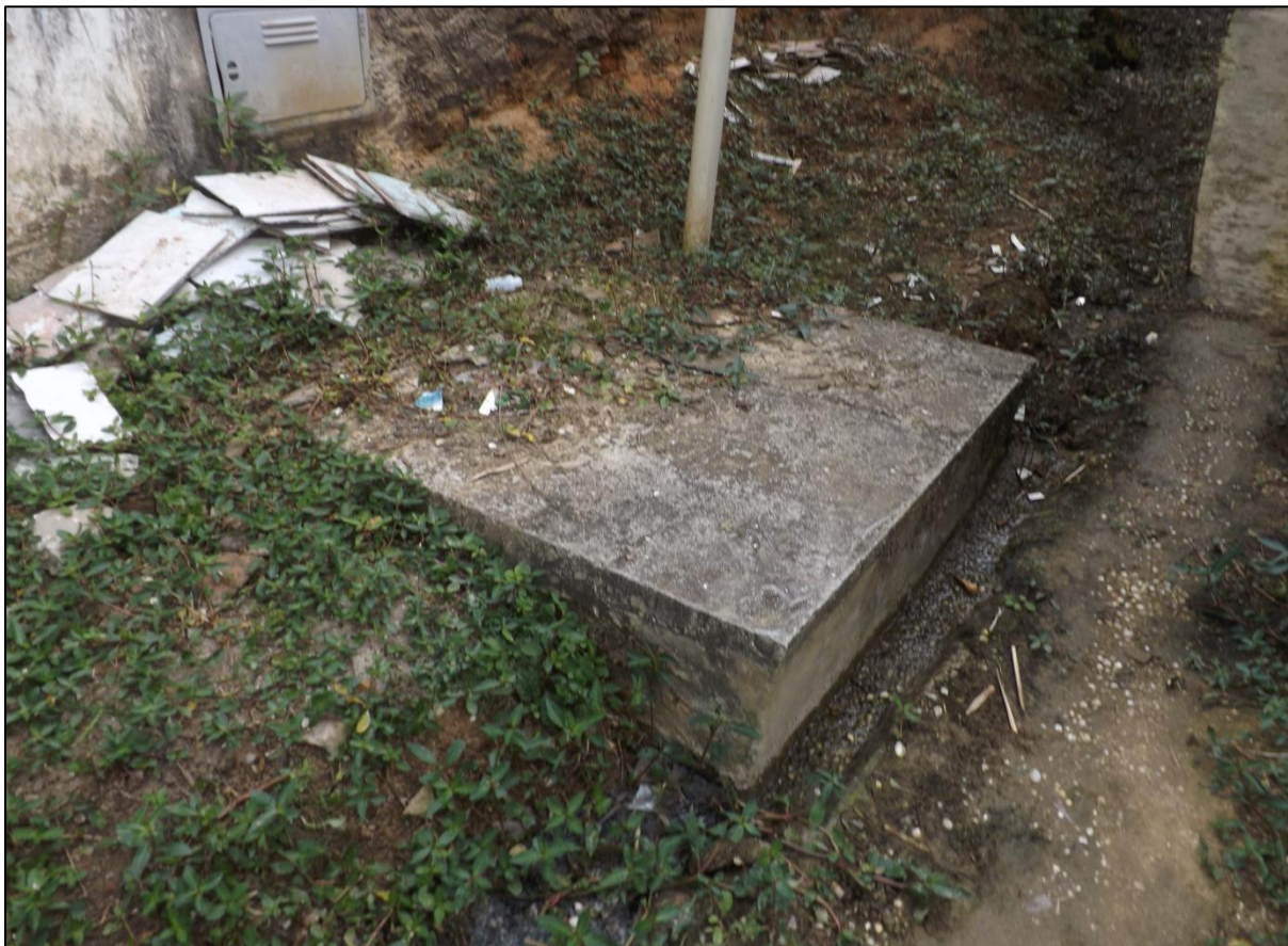
Figura 10 – Fossa para descarte de dejetos em Praia Grande, Ilha de Maré, Salvador-BA.
