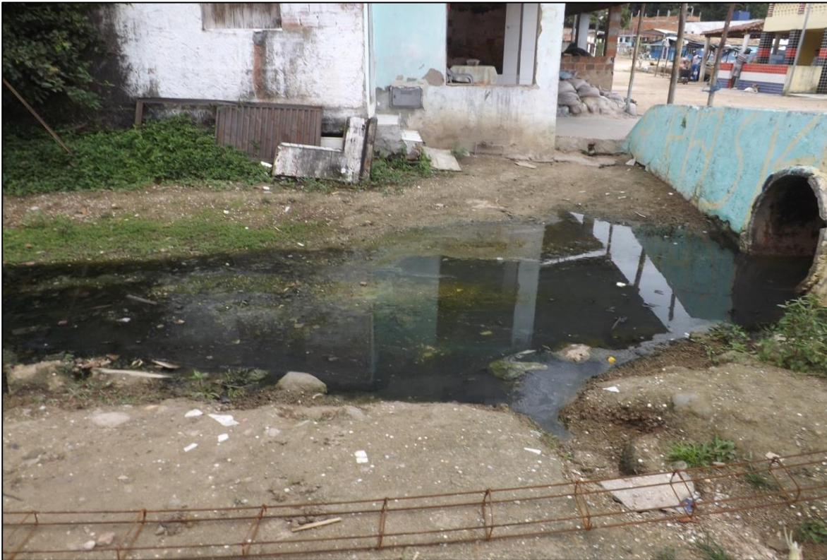
Figura 22 – Esgoto a céu aberto na Rua do Beco, Praia Grande, Ilha de Maré, Salvador-BA.
