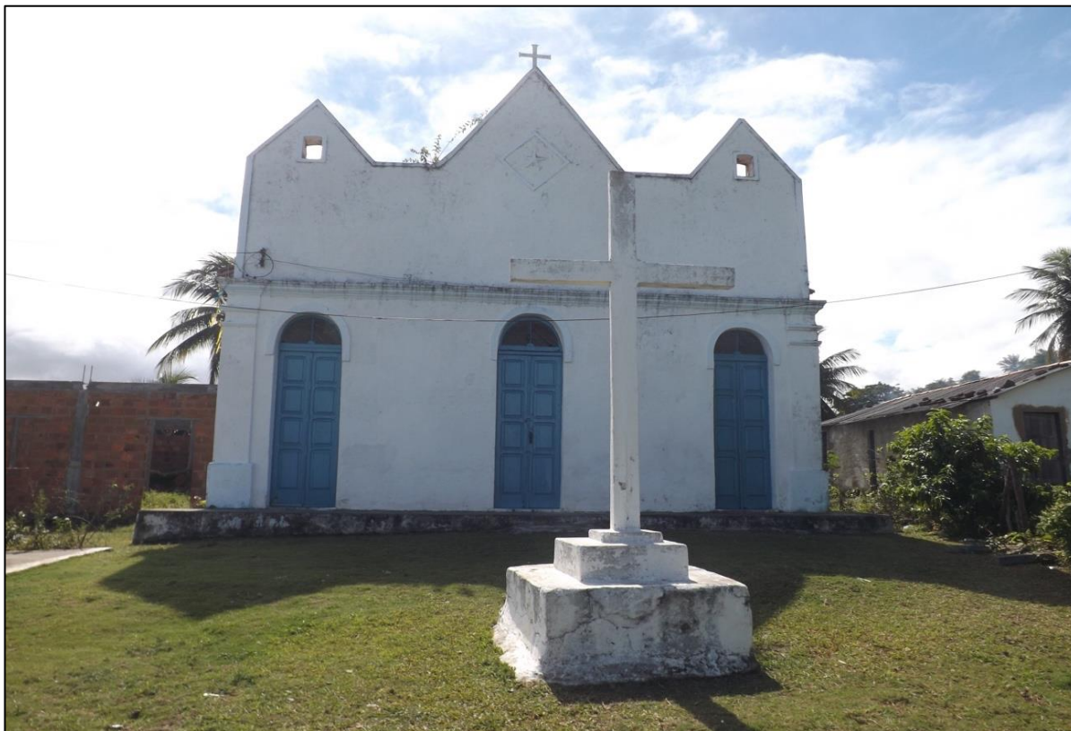
Figura 18 – Igreja Católica localizada no alto da Rua da Caieira, Praia Grande, Ilha de Maré, Salvador-BA.
