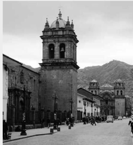
370. Finalização do encaminhamento perspectivo da “Via Sacra”. A animação se deve, cenograficamente, ao campanário de Santa Clara e à fachada de San Pedro, frontaria que emoldura, parcialmente, a fuga em profundidade. Fonte: Fotografia elaborada pelo autor (2007).
