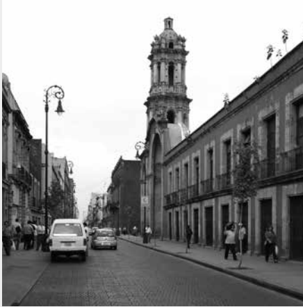
394. Perspectiva da Calle República de El Salvador, no centro histórico da capital mexicana, com destaque para a torre do complexo do Oratório de San Felipe Neri, edificada na segunda metade do século XVIII. Fonte: Fotografia elaborada pelo autor (2009).
