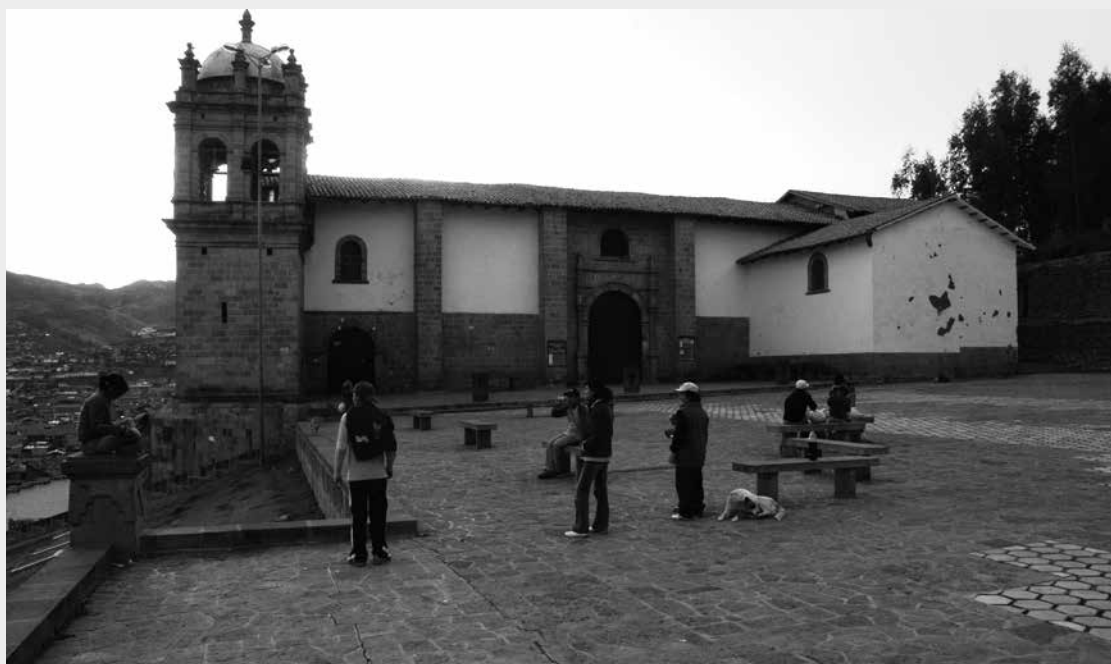
379. A igreja paroquial disposta na Colina de San Cristóbal. Fonte: Fotografia elaborada pelo autor (2007).
