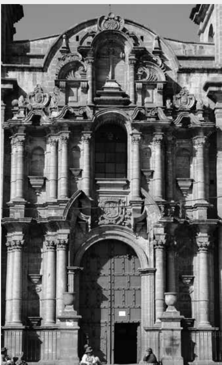
372. Fachada-retábulo da Igreja de San Pedro. Fonte: Fotografia elaborada pelo autor (2007).
