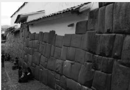
333. Casarões coloniais cusqueños construídos acima de alicerces e de muros incas remanescentes. Fonte: Fotografia elaborada pelo autor (2007).
