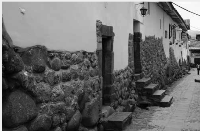
382: Rua do Bairro de San Blas. Fonte: Fotografia elaborada pelo autor (2007).
