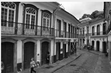
263. Trecho do “caminho novo” na Freguesia do Pilar. A Rua São José. Fonte: Fotografia elaborada pelo autor (2017).
