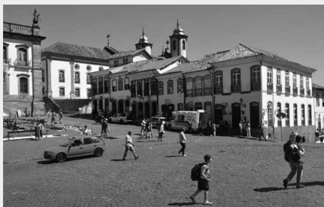
295. Detalhe do casario da atual Praça Tiradentes. Fonte: Fotografia elaborada pelo autor (2014).
