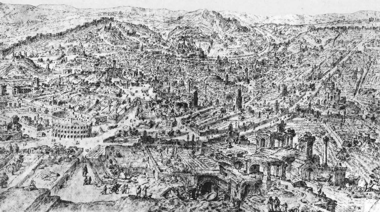
154. Veduta del Colle Oppio , 1550. Por Hendrik van Cleve (1525-1589). Percebe-se, na vista do pintor e gravurista flamengo, a área desolada, pontuada por campos e ruínas, que antes marcava o coração da Roma republicana e imperial – com destaque para o Colosseo. Fonte: Insolera (1996, p. 125).
