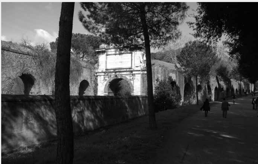
155. Acquedotto dell'Acqua Paola e Arco di Tiradiavoli percorrendo a área verde da colina do Gianicolo, em Roma. O aqueduto foi fruto da restauração do antigo Acquedotto Traiano pelo Papa Paulo V (1552-1621), no início do século XVII. O papa também construiu, em 1612, o Arco de Tiradiavoli para permitir que a Via Aurelia Antica passasse abaixo de seu aqueduto. Fonte: Fotografia elaborada pelo autor (2007).
