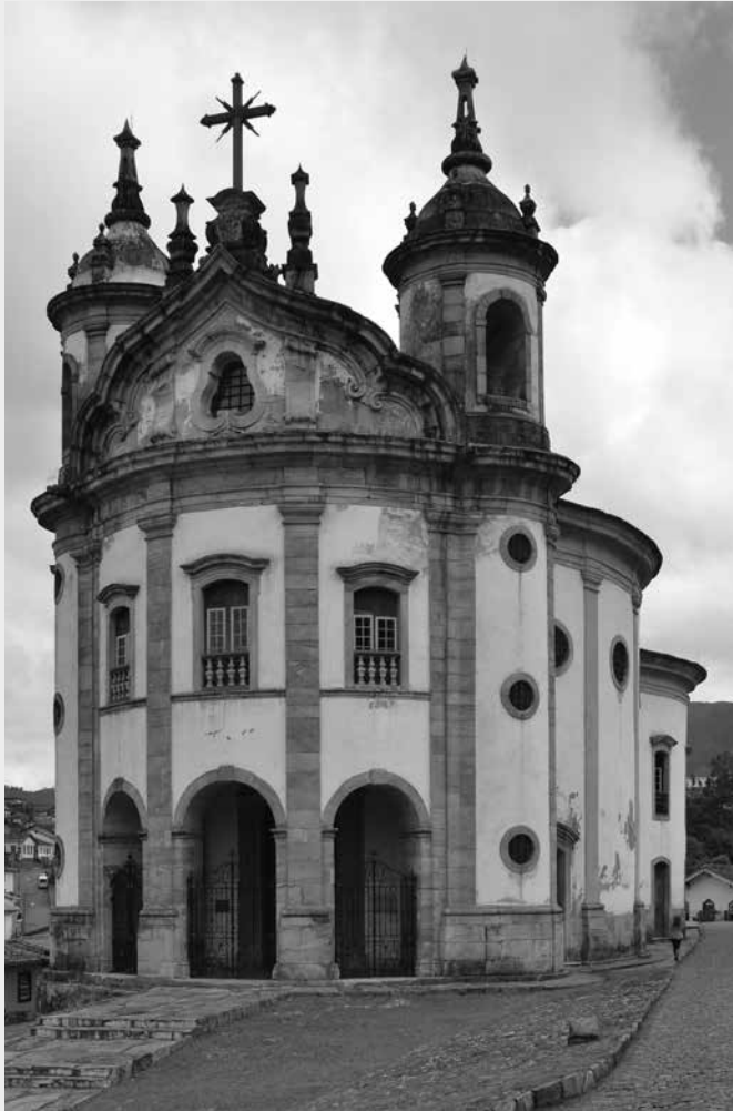
271. Igreja de Nossa Senhora do Rosário dos Pretos vista de frente e em escorço. Fonte: Fotografia elaborada pelo autor (2017).
