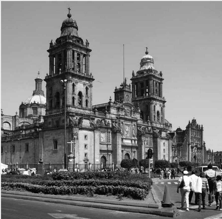
392. Grandiosa mole da Catedral Metropolitana do México lançada no vazio do Zócalo, flanqueada por uma das fachadas-retábulo churrigueresca do Sagrario. O edifício da Catedral – que se voltaria de frente à praça – seria iniciado em 1563 segundo projeto do arquiteto espanhol Claudio de Arciniega (1527-1593). O Sagrario seria projetado pelo mestre espanhol, radicado no México, Lorenzo Rodríguez (1704-1774) e construído na segunda metade do século. Fonte: Fotografia elaborada pelo autor (2009).
