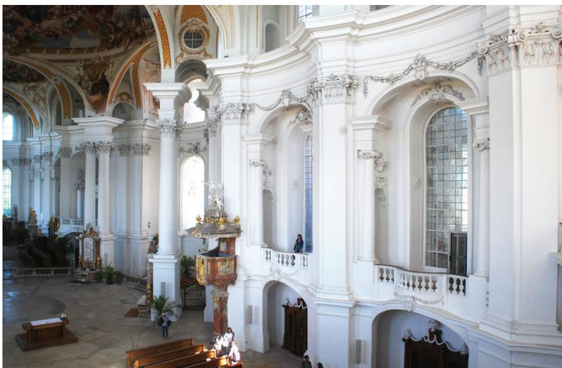
FIGURA 44: Detalhe dos pilares de sustentação da abóbada da Igreja da Abadia Beneditina de Neresheim. Devido ao uso dos arcos estruturais de dupla curvatura é possível perceber como os apoios estruturais não conformariam uma sequência linear de pilares, mas modelariam os sucessivos espaços elípticos que comporiam o interior do edifício. Fotografia elaborada pelo autor em 2012.
