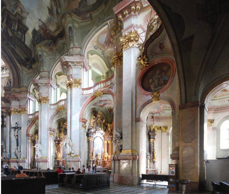
FIGURA 40: Imagem mostrando os pilares de sustentação da abóbada da nave da Igreja de São Nicolau, em Malá Strana. O esquema estrutural seria inspirado nas igrejas de salão (*hallenkirche*) do gótico alemão. Um mecanismo que permitiria a sustentação independente das abóbadas oferecendo grande permeabilidade ao espaço – que se abriria ao exterior pelas capelas laterais e pelas tribunas superiores. Fotografia elaborada pelo autor em 2012.
