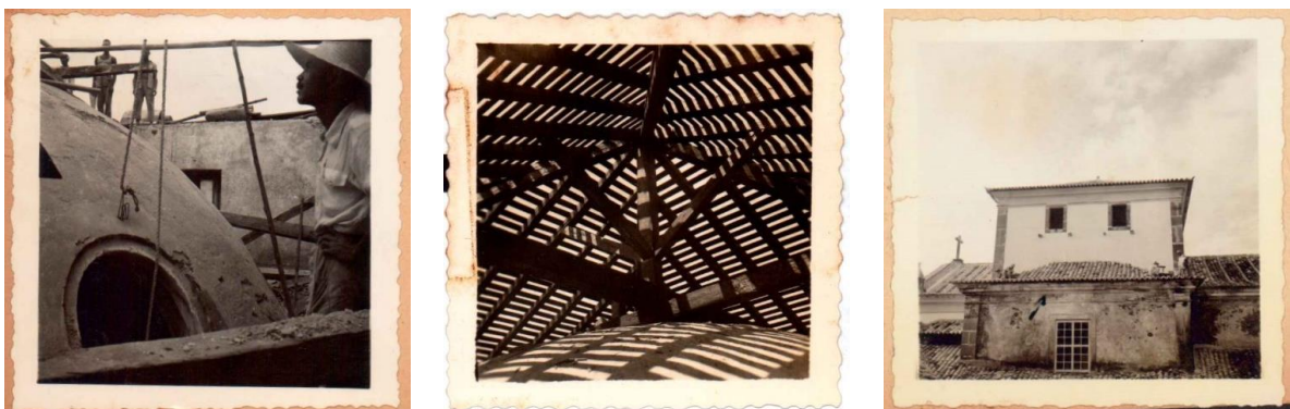
Figuras 14, 15 e 16. Nova Cúpula sendo construídas. Fotografia, 1953.
