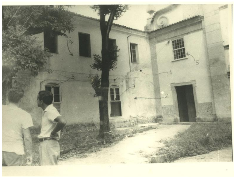
Figura 02: “Pátio Ajardinado”, Fachada da Igreja – fachada lateral da extensão demolida, ver Anexo P. Fotografia, 1940[?].
