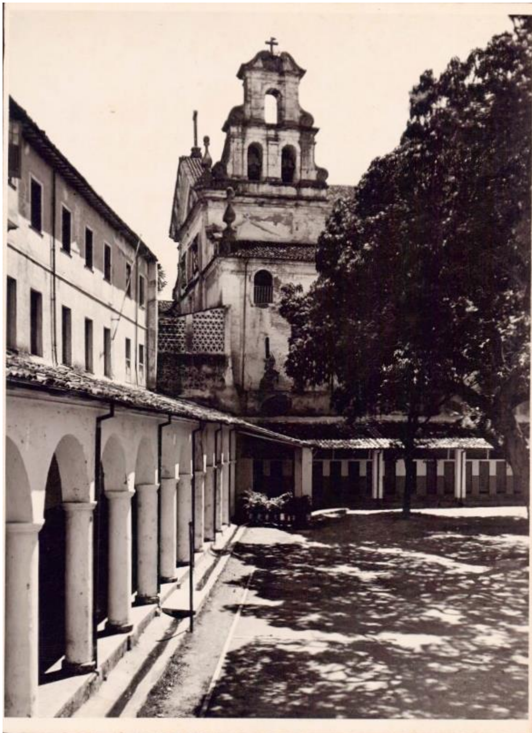
Figura 08: “Área descoberta, Recreio do Seminário Menor” – Fachada interna da extensão demolida, ver Anexo P. Fotografia, 1940 [?].
