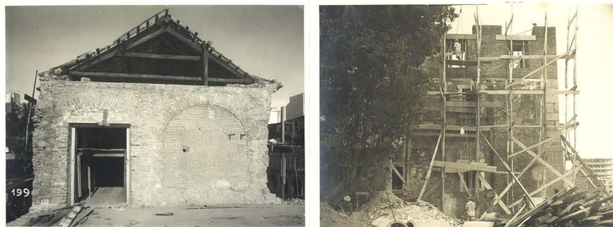
Figuras 29 e 30. Reconstrução de salão adaptado – cômodo na ala poente, 5º piso. Fotografia, Jul. - Dez. 1958[?]
