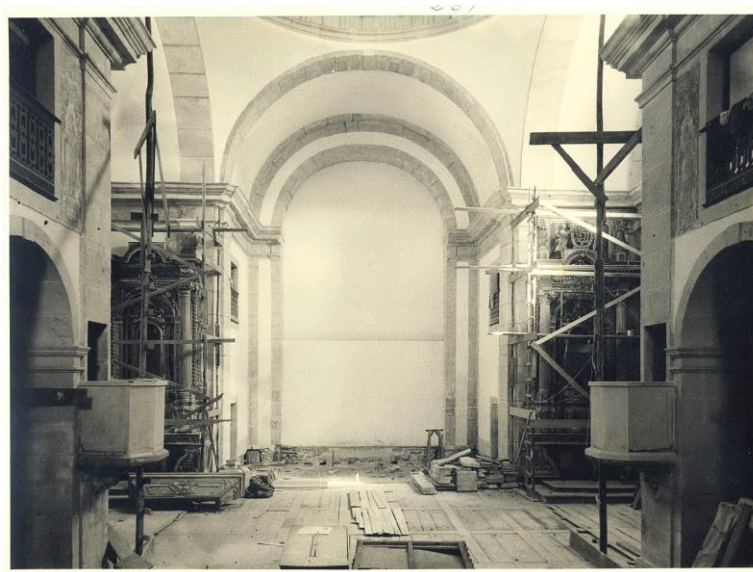
Figura 33. Interior da Igreja de Santa Teresa – andaime para o revestimento no teto da nave. Fotografia, Out. 1958[?].
