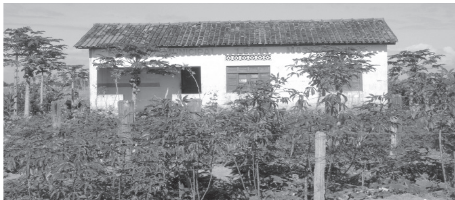
Figura 10 - Escola municipal na rodovia Itamarajú – Prado
