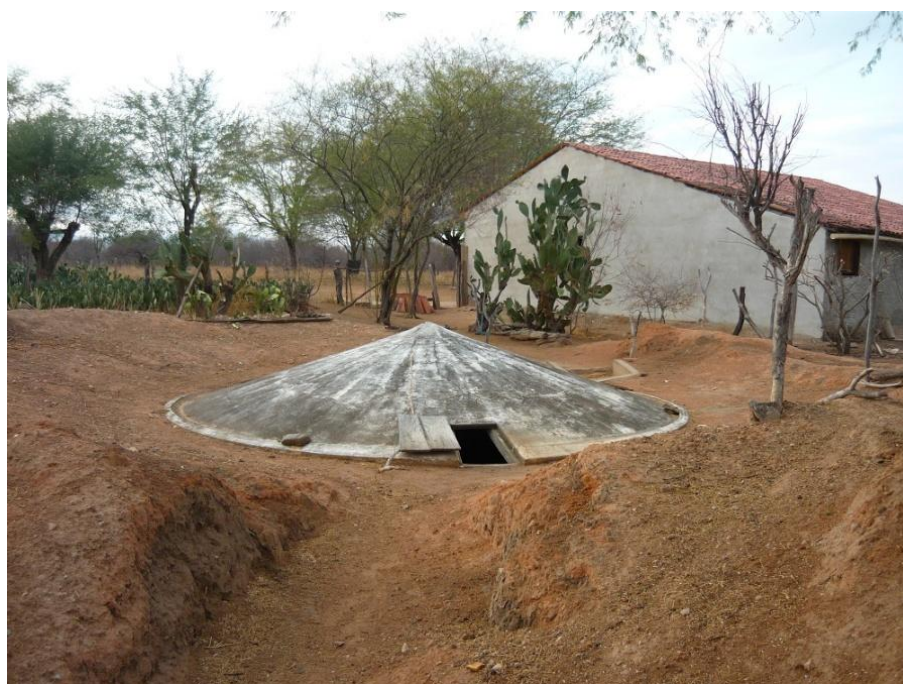
Foto 19: Cisterna de enxurrada 265 localizada no quintal da casa de Nilza. (Várzea Grande, 2011)
