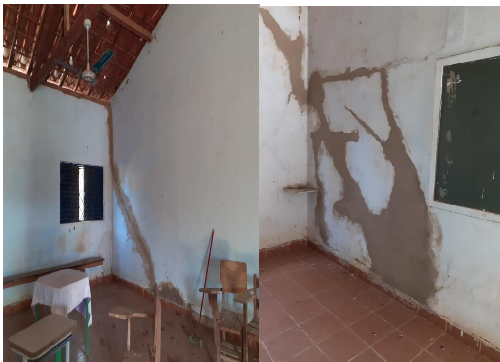
Figura 55 -e Figura 56 - Parte interna das salas da Escola depois da reforma.
