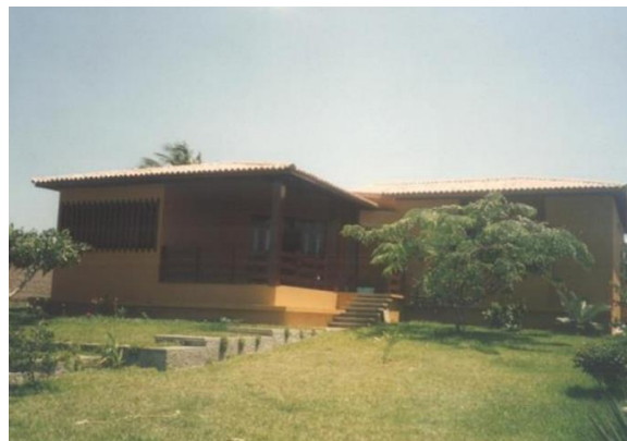
Projeto Arquitetônico da Residência de Campo do Sr. João Lycio C.Filho, localizada no Condomínio Chácaras do Jacuípe, Qd/ -L/4 (300 m 2 ) - 1993.
