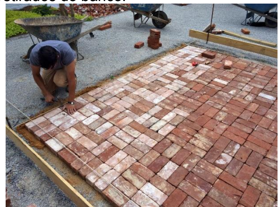
Figuras 51 e 52 – Biblioteca de Newbern. Rural Studio. Construção do muro e pavimentação do jardim lateral com aproveitamento dos tijolos retirados do banco.
