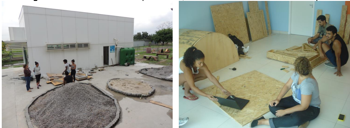
Figuras 96 e 97 – Canteiro Experimental, FAU-UFRJ. Radier e Módulo de Apoio.
