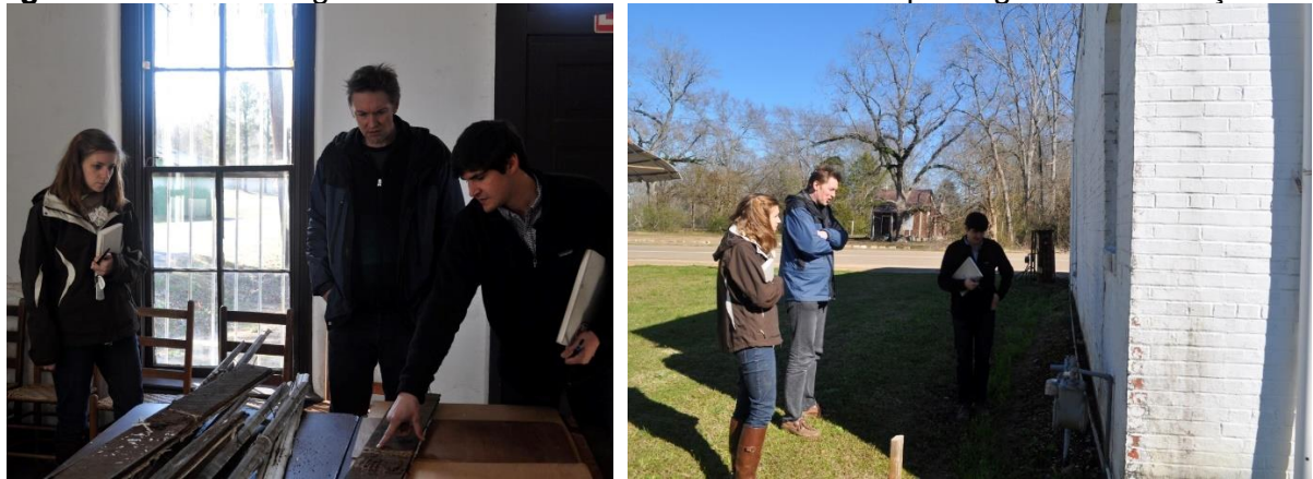
Figuras 24 e 25 – Antigo Banco de Newbern. Consultoria sobre patologias da construção.
