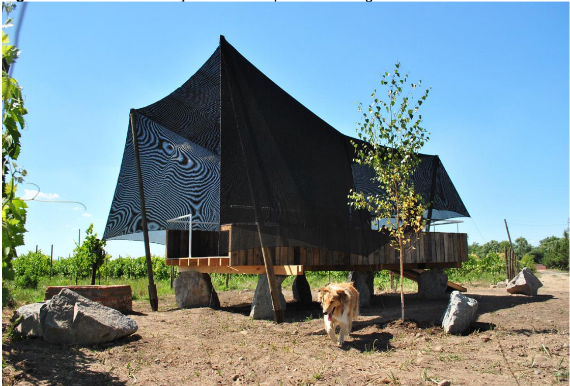
Figura 89 – Obra de Titulação. Autor: Arq. Javier Rodriguez Acevedo. 2010.
