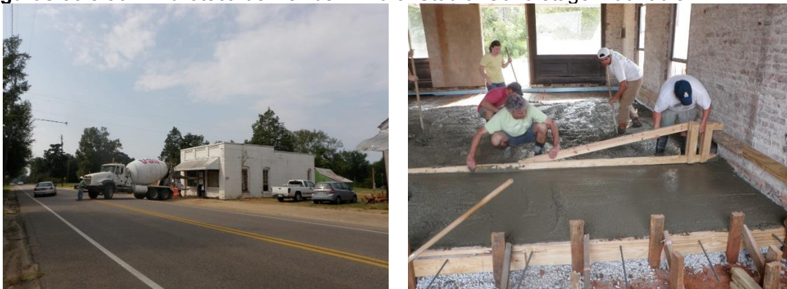
Figuras 35 e 36 – Biblioteca de Newbern. Rural Studio. Concretagem do radier.
