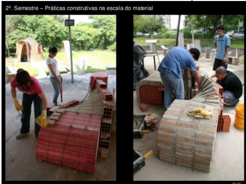
Figura 93 – Práticas Construtivas em Escala 1:1. Canteiro Experimental FAU-USP.
