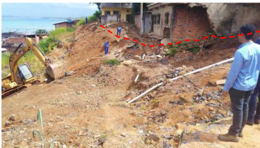
Figura 4.9 – Local onde ocorreu o deslizamento. Em destaque, a crista da superfície de escorregamento.
