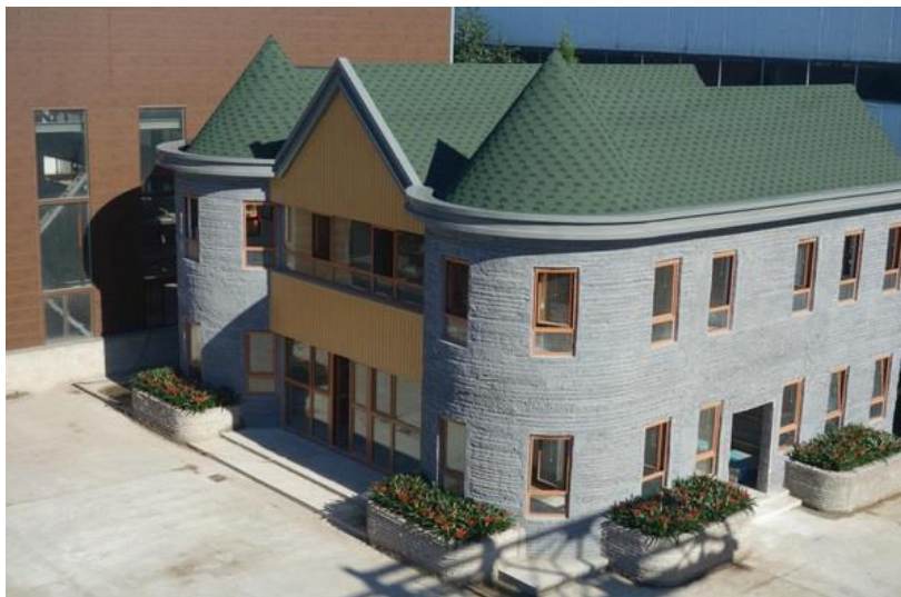
Figura 21 – Edifício construído com impressora 3D para concretos.
