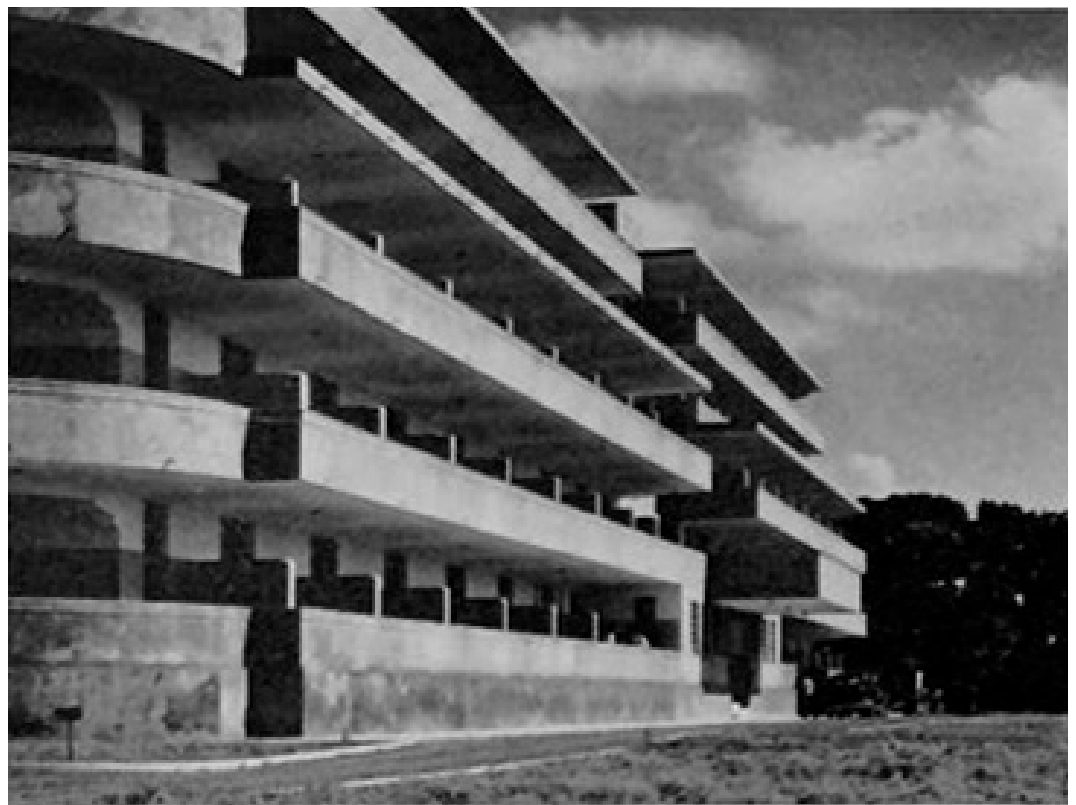
Figuras 25 e 26 Sanatório de Tuberculose Santa Terezinha selecionado para representar a arquitetura moderna baiana no livro Brazil Builds . Importante observar que, na publicação do Brazil Builds , optou-se por fotografia em ângulo ligeiramente diverso do escolhido na maioria das fotos do Santa Terezinha feitas à época - as extremidades arredondadas estão quase suprimidas, e evidencia-se, como em nenhuma outra foto encontrada, o balanço e as linhas retas que caracterizam os solários. Fonte: GOODWIN, 1943, p. 134.
