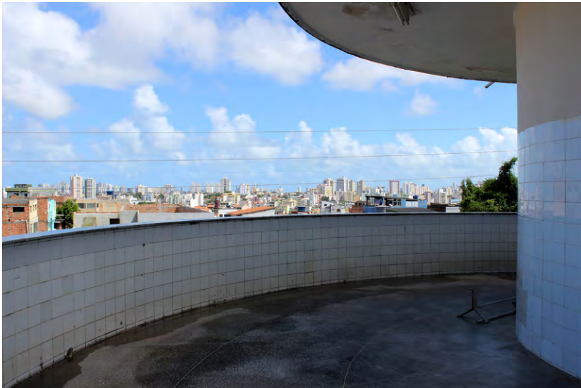
Figura 93 Fotografia tirada a partir do terceiro pavimento da extremidade sul do Hospital Santa Terezinha. Fonte: tirada pela autora, 2018
