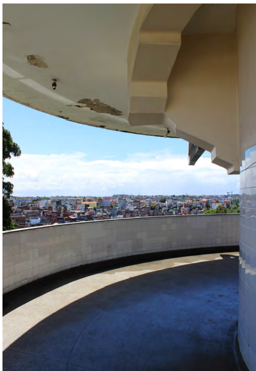
Figuras 165 e 166 À esquerda, solário da ala norte do segundo pavimento (ala d); à direita, varanda arredondada da extremidade da ala norte do segundo pavimento (ala d). locais onde foram retiradas amostras na laje para testes diversos
