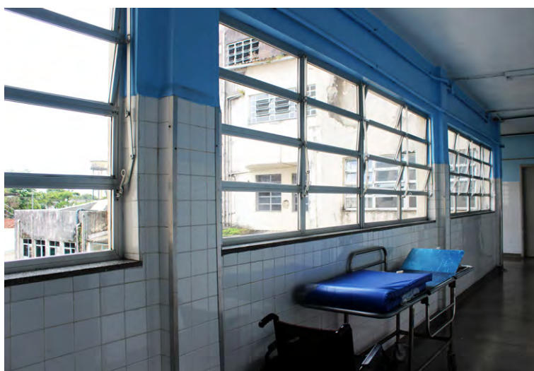
Figura 130 Acima, à esquerda. Esquadrias originais, circulação ala norte. Fonte: Acervo HEOM, 2004
