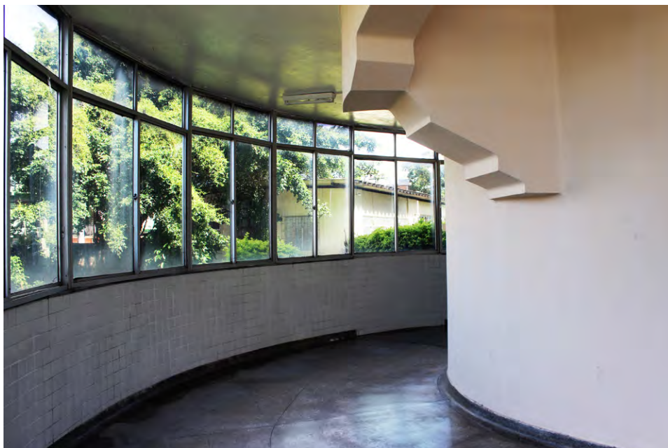
Figuras 114, 115, 116 e 117 Encontro entre viga em arco das extremidades arredondadas com caixa de escada. Acima, ala sul (térreo). À esquerda, ala norte (térreo). No centro, ala norte (1º pavimento). À direita, ala sul (1º pavimento). Fonte: tiradas pela autora, 2018
