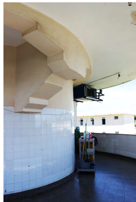
Figuras 114, 115, 116 e 117 Encontro entre viga em arco das extremidades arredondadas com caixa de escada. Acima, ala sul (térreo). À esquerda, ala norte (térreo). No centro, ala norte (1º pavimento). À direita, ala sul (1º pavimento). Fonte: tiradas pela autora, 2018
