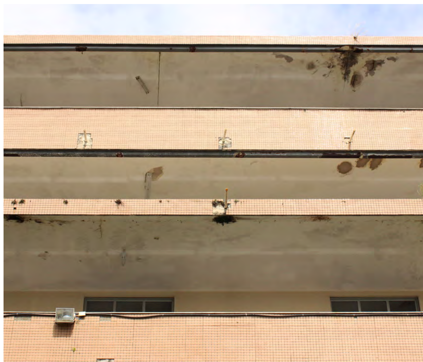
Figura 156 Fotografia aproximada dos balcões, mostrando o descolamento das pastilhas ao redor dos buzinotes. Fonte: tirada pela autora, 2018
