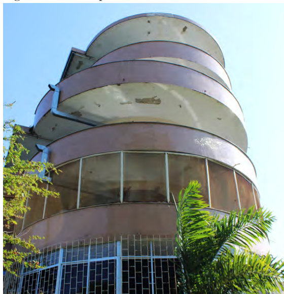
Figura 160 Foto aproximada mostrando danos manifestados na extremidade arredondada da ala norte. Fonte: tirada pela autora, 2018
