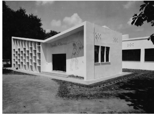
Figura 86 À esquerda, Centro Educacional Carneiro Ribeiro: Escola Parque - Pavilhão de Educação Física e Recreação. Fonte: Acervo Centro Educacional Carneiro Ribeiro apud ANDRADE JUNIOR..., 2016, p. 214 Figura 87 À direita, Centro Educacional Carneiro Ribeiro: Escola-Classe III. Fonte: Acervo CEAB/FAUFBA apud ANDRADE JUNIOR..., 2016, p. 204
