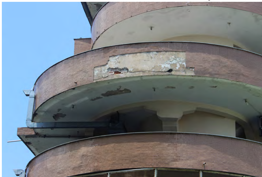
Figura 160 Foto aproximada mostrando danos manifestados na extremidade arredondada da ala norte. Fonte: tirada pela autora, 2018
