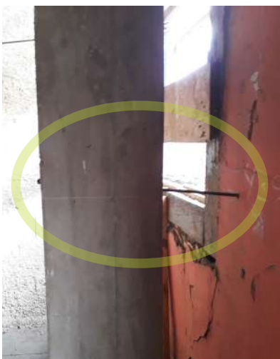
Figura 85 - Pilar parafusado à alvenaria
