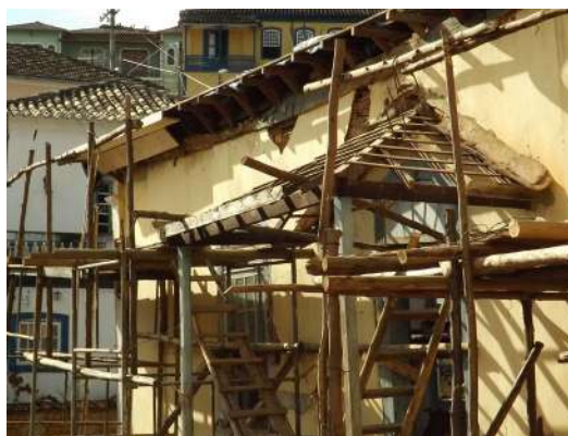
Figura 129 - Telhado da varanda
