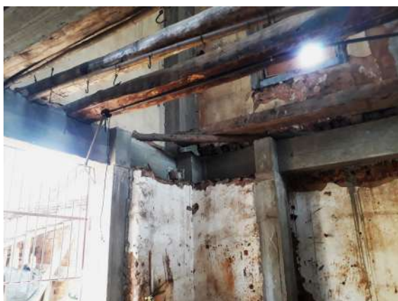
Figura 80 - Conexão do vigamento
