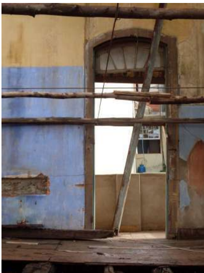
Figura 110 - Vão de acesso à varanda
