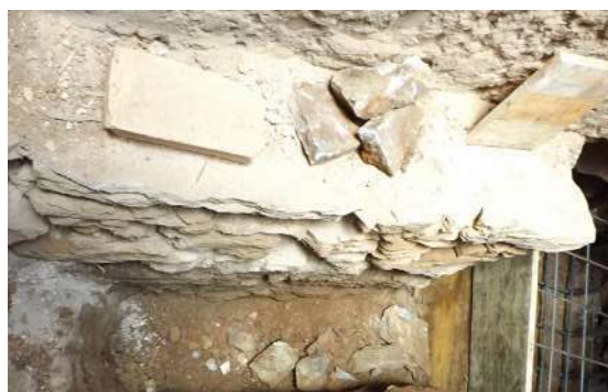
Figura 60 - Fundação em linha contínua
