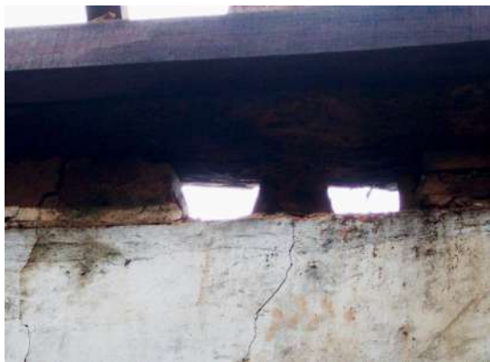
Figura 225 - Detalhe de fixação do esteio no frechal
