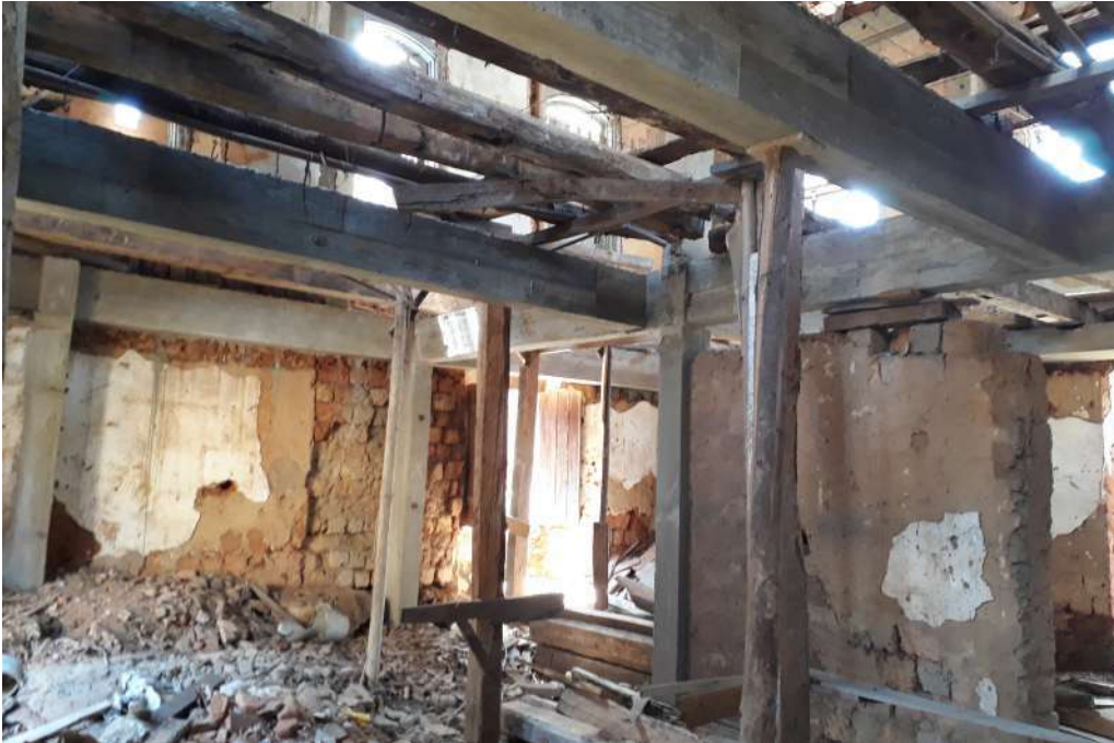
Caderno 2 Foto 27: Salão da Fábrica visto do acesso de fundos
