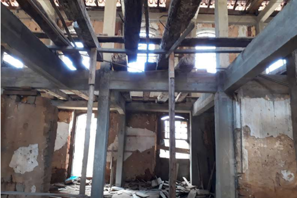
Caderno 2 Foto 28: Salão da Fábrica visto do acesso de fundos
