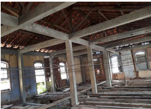
Figura 162 - Vista pavimento superior
