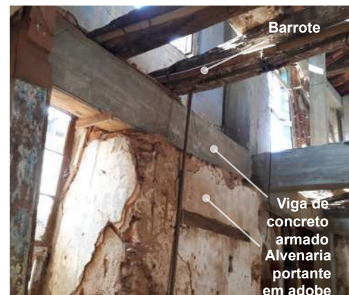
Figura 79 - Sistema de vigamento
