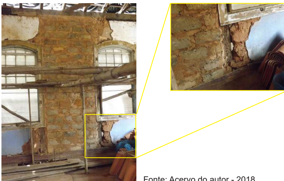
Figura 156 - Adobe compondo a vedação da gaiola na fachada principal
