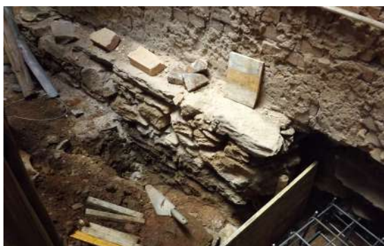
Figura 59 - Fundação em linha contínua
