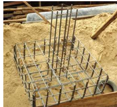
Figura 71 - Ferragem armada
