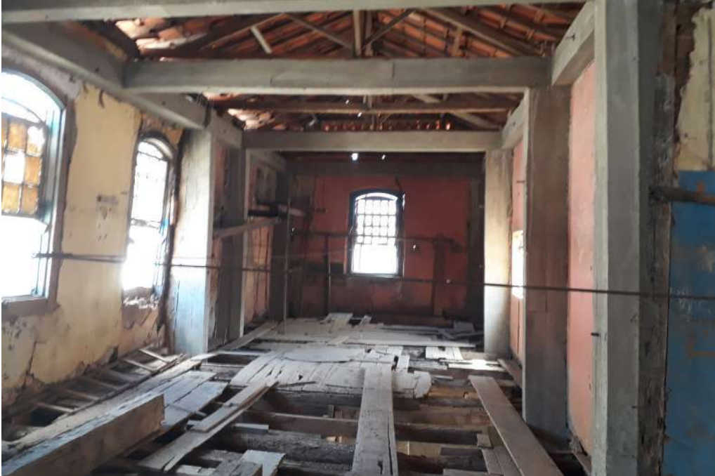
Caderno 2 Foto 40: Vista do retângulo menor na planta em “L” no pavimento superior.
