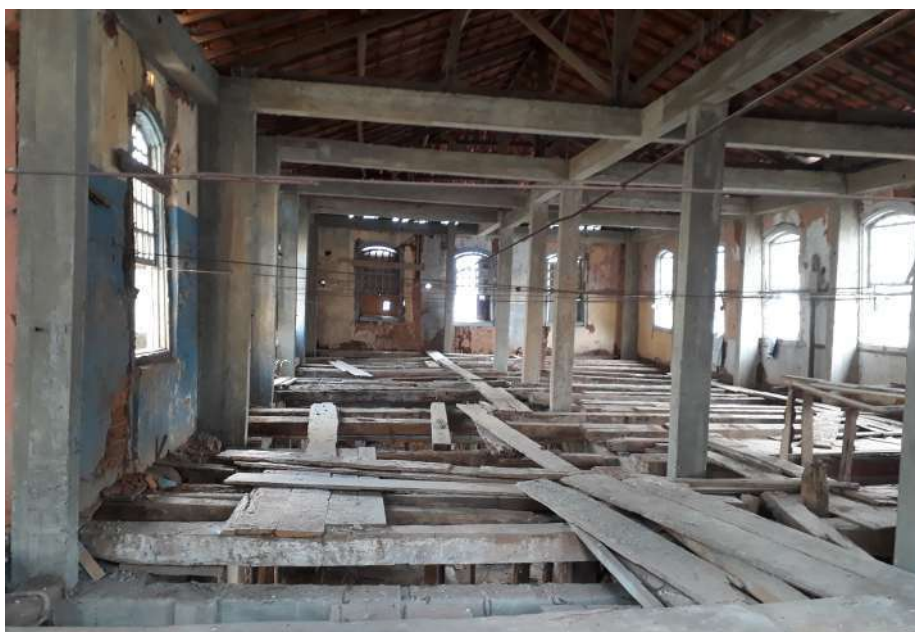
Figura 202 - Vista do pavimento superior
