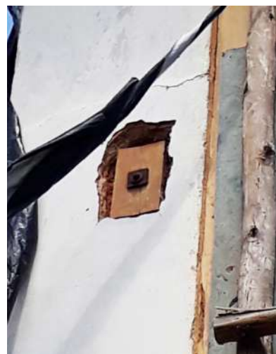
Figura 86 - Pilar parafusado à alvenaria
