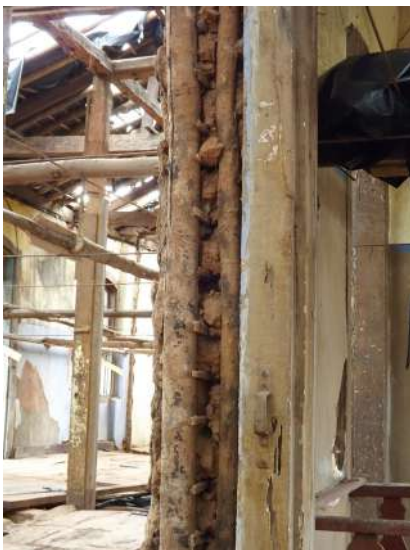
Figura 92 - Parede em pau a pique Pau e varas ainda com preenchimento
