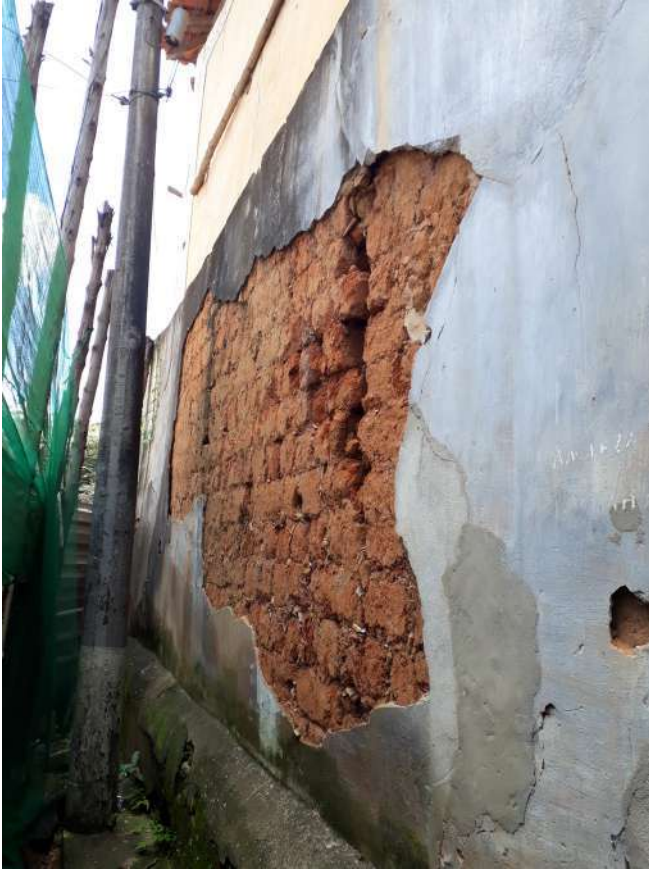
Caderno 2 Foto 50: Rachadura em progresso no pavimento térreo.
