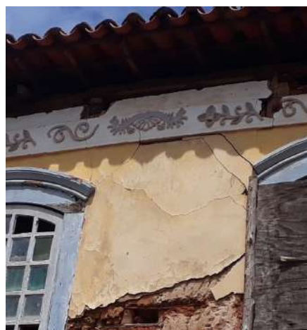
Figura 240 - Rachadura arqueada
