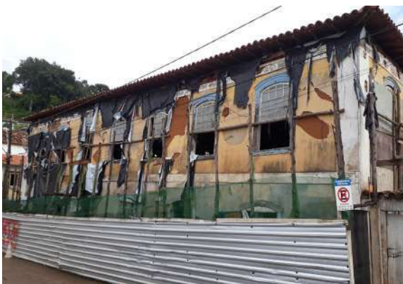
Figura 193 - Casarão Selaria Estrela - Vista externa
