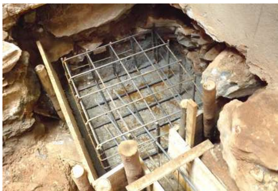
Figura 73 - Cova da nova fundação
