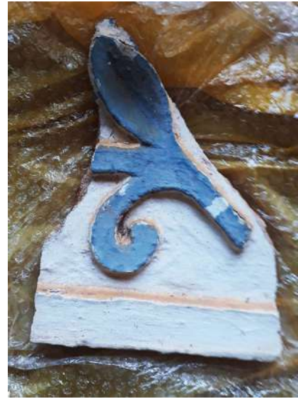
Figura 173 - Placa de reboco desprendida
