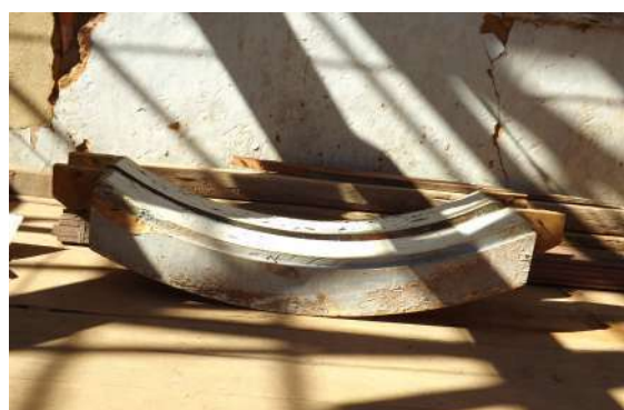
Figura 109 - Verga desmontada
