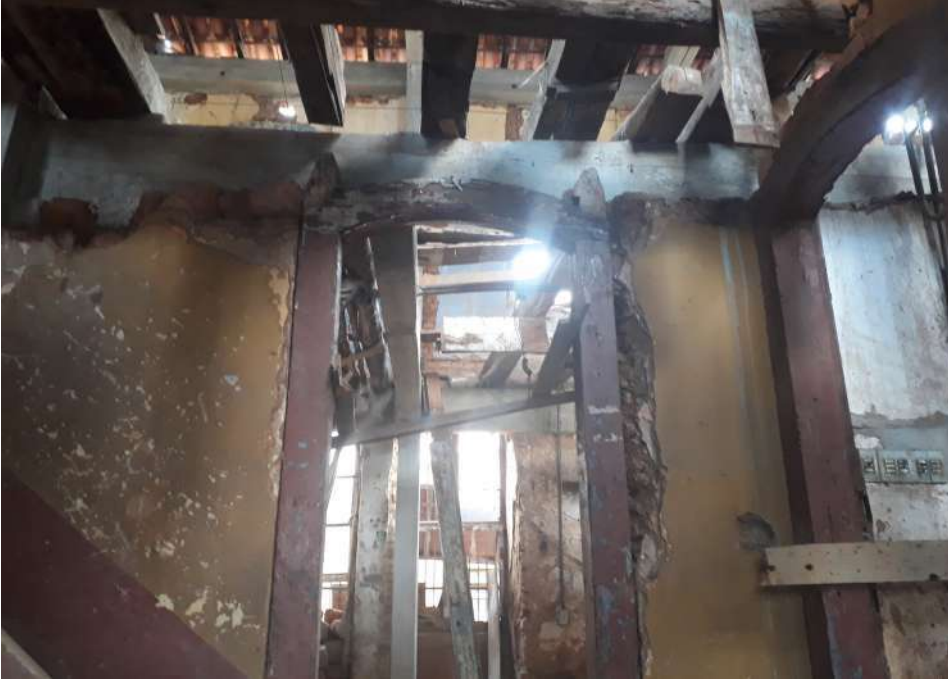
Caderno 2 Foto 24: Sala de acesso. Detalhe das pontas dos esteios que se cravavam numa madre, já retirada.
