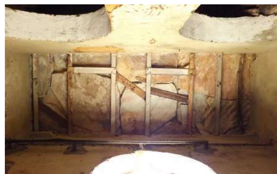
Figura 103 - Laje do piso da varanda
