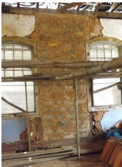
Figura 90 - Vedação em adobe no primeiro pavimento
