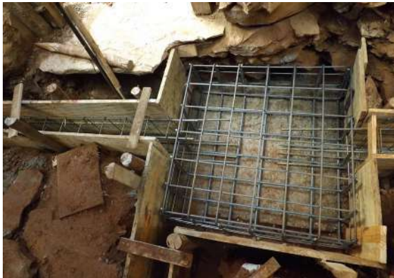
Figura 190 - Início da construção das sapatas em concreto armado
