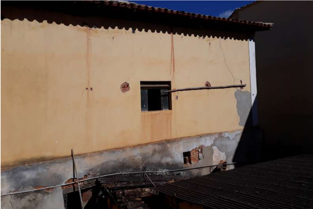
Caderno 2 Foto 41: Vista da esquadria metálica atemporal à construção original a partir da varanda dos fundos
