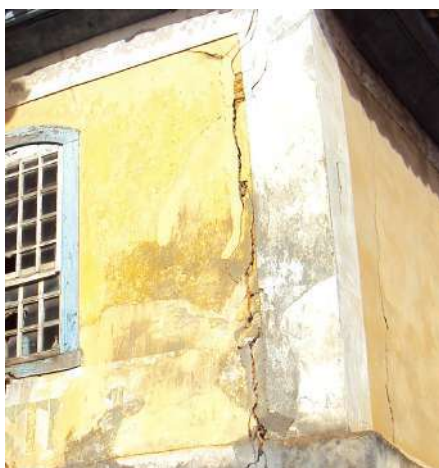
Figura 239 - Rachadura vertical
