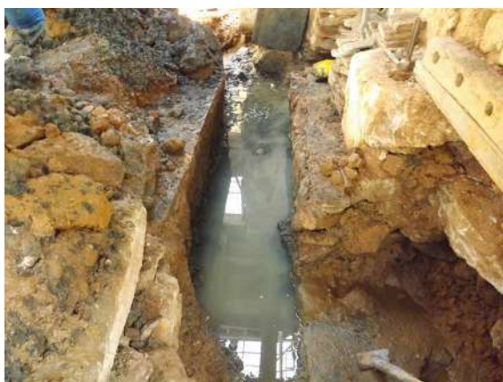
Figura 149 - Água no subsolo
