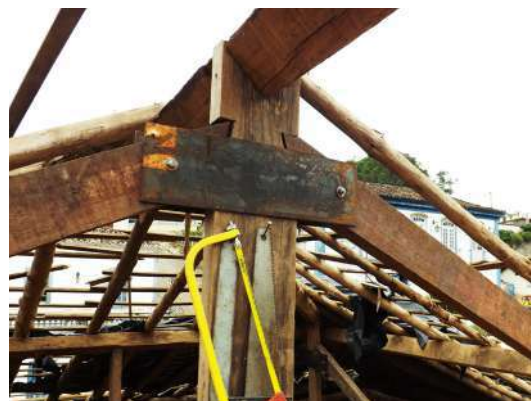
Figura 125 - Chapa de travamento
