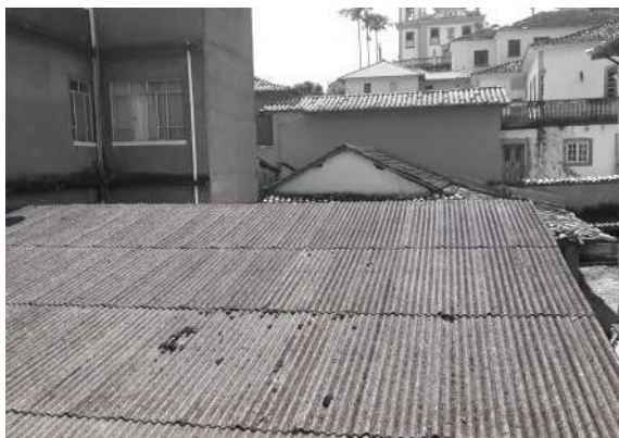
Figura 200 - Vista do telhado do anexo
