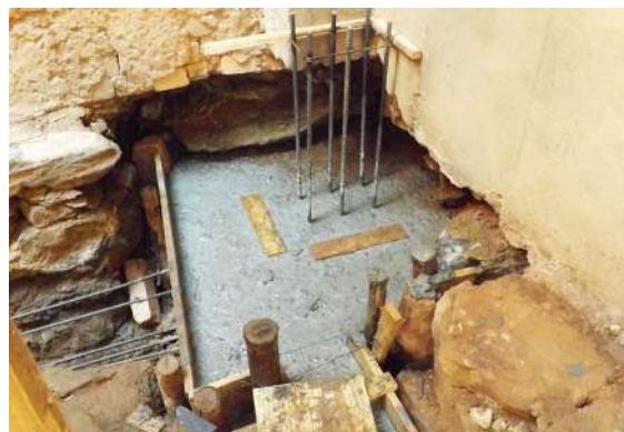
Figura 74 - Nova fundação concretada
