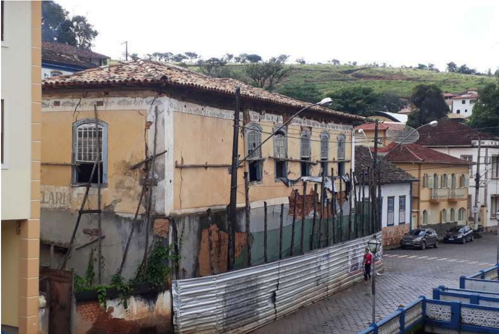
Caderno 2 Foto 22: Vista da sacada do prédio da agência dos Correios
