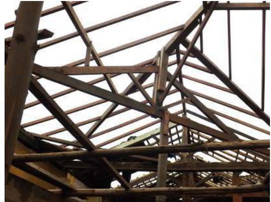
Figura 121 - Tesoura de espigão
