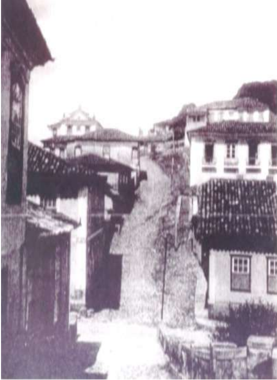
Caderno 1 Foto 14: Vista a partir da Rua Cel. José Manuel com a Capela N. Sra. do Rosário ao fundo
