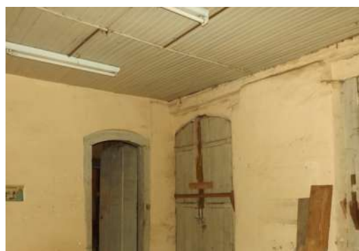
Figura 105 - Tabuado em régulas finas
