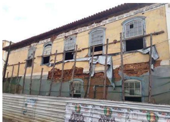
Figura 197 - Vista externa do Casarão para a Tv. Ver. José M. da Costa
