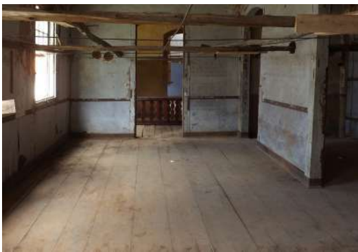
Figura 100 - Tabuado primeiro pavim.
