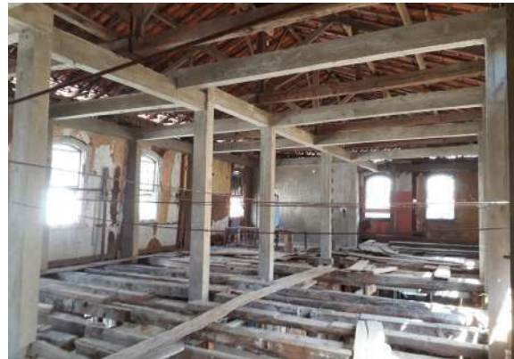
Figura 191 - Estrutura em concreto armado concluída - Primeiro pavimento
