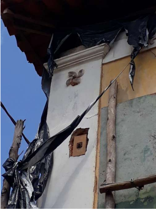
Caderno 2 Foto 51: Detalhe do retentor de madeira preso ao tirante metálico
