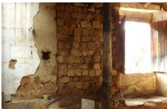
Figura 227 - Engrossamento da alvenaria portante suprimido
