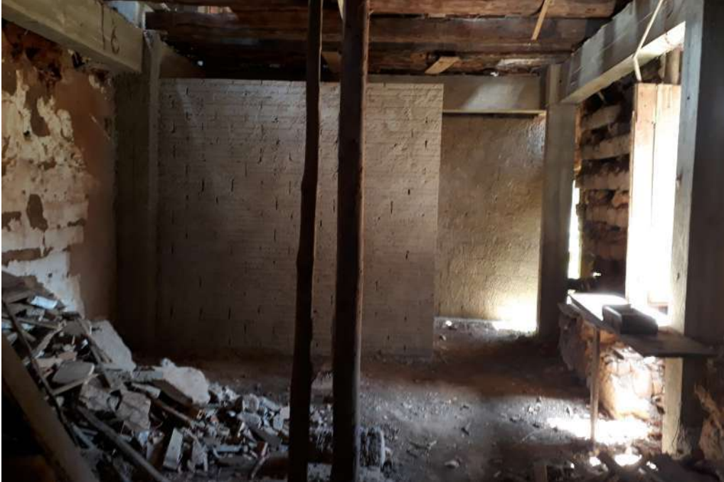
Caderno 2 Foto 33: Vista dos fundos do salão da Fábrica. Paredes em tijolo furados erguidas ao fim do ano de 2015
