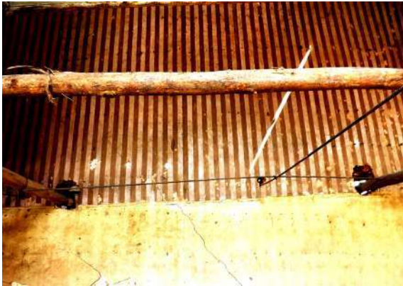
Figura 194 - Papel de parede remanescente no pavimento superior
