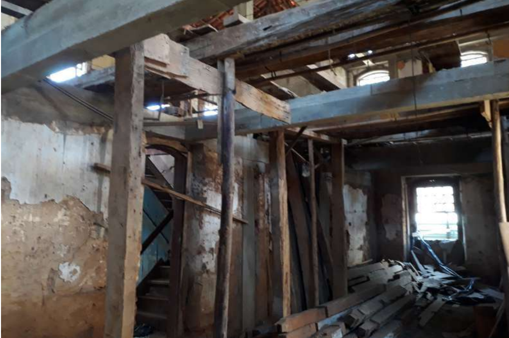
Caderno 2 Foto 29: Salão da Fábrica visto do acesso de fundos
