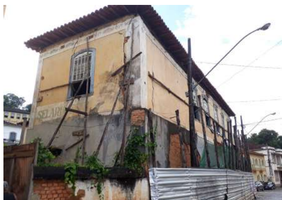
Figura 196 - Vista externa do Casarão para a Tv. Ver. José M. da Costa
