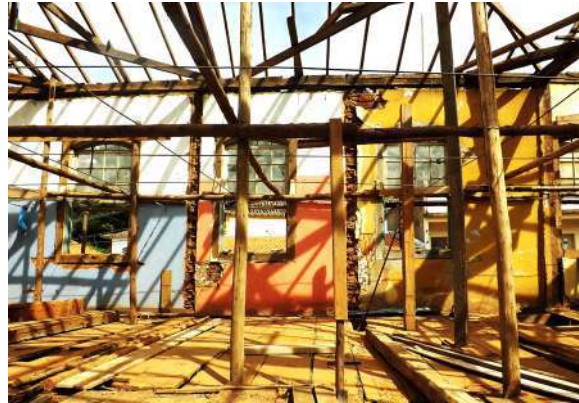
Figura 195 - Pinturas remanescentes no pavimento superior
