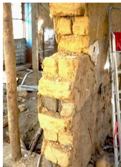
Figura 89 - Parede em adobe
